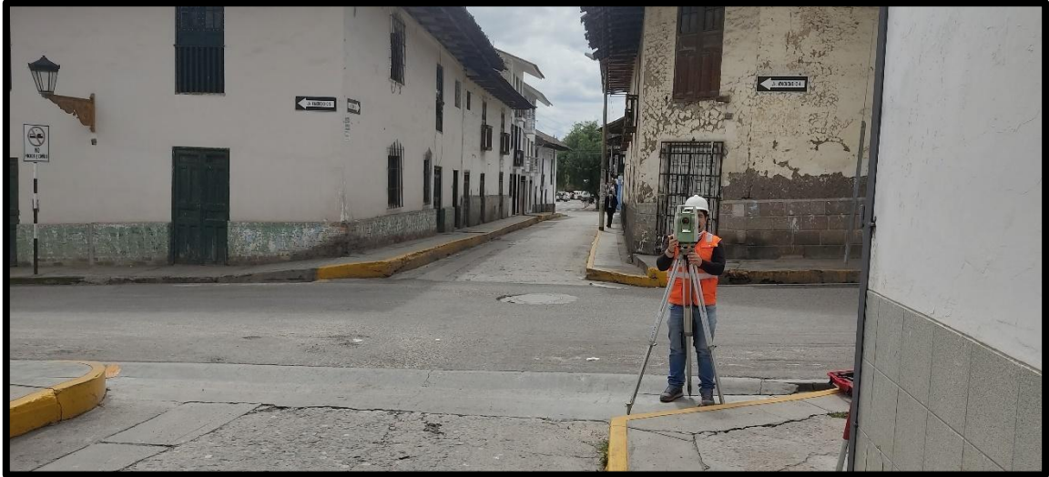
Verificación de puntos topográficos en Jr. Eten intersección con Jr. Ayacucho.
