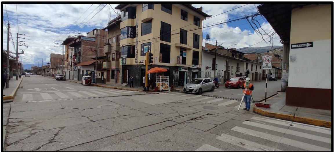
Verificación de puntos topográficos en Jr. Mario Urteaga intersección con Jr. Guillermo Urrelo.
