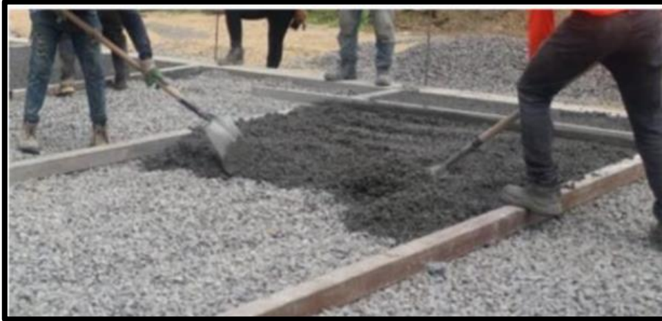
Figura 03. Concreto permeable como capa de rodadura
