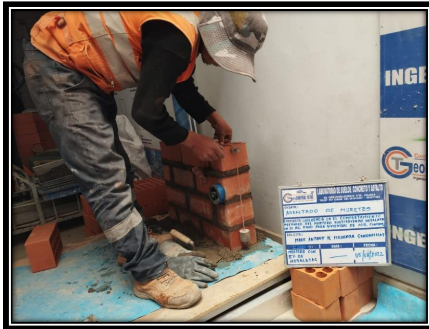
Figura 49: Asentado de muretes.
