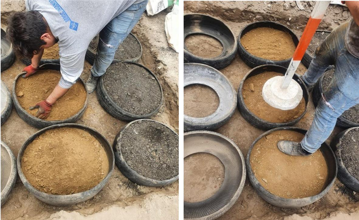
*Figura 27. Geocilindros con afirmado*
