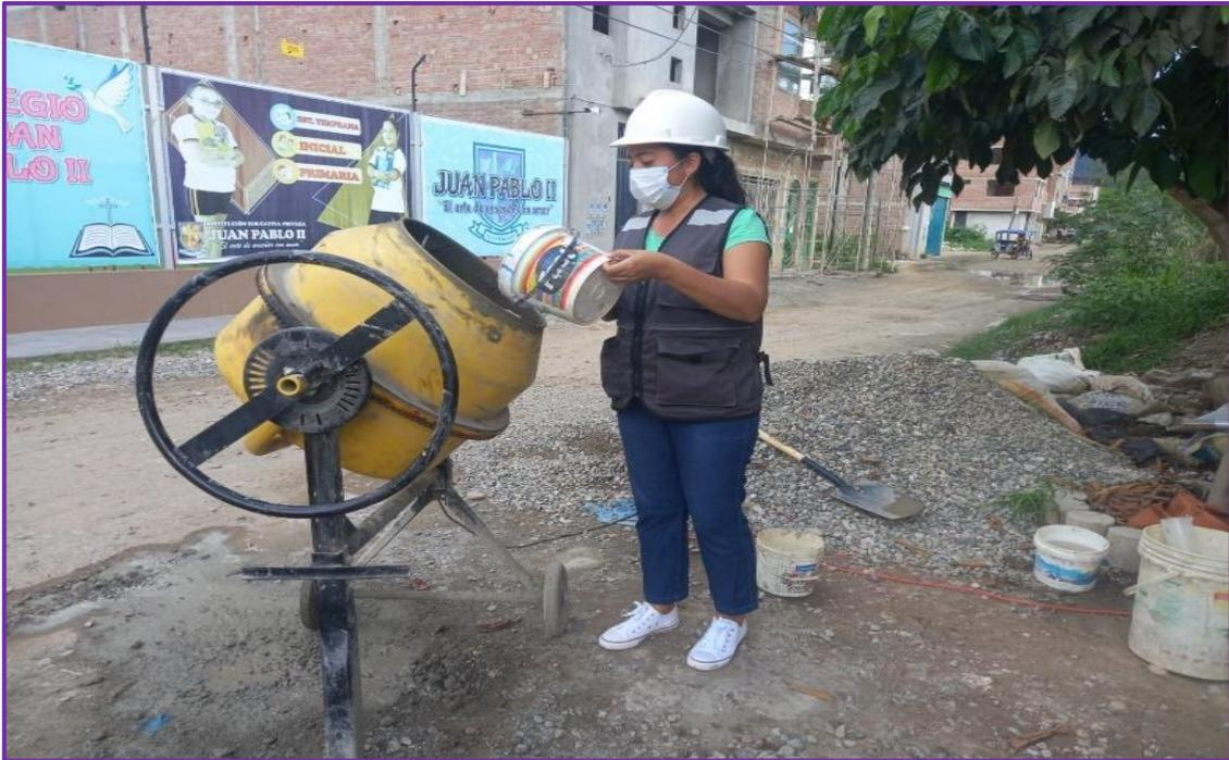
FOTOGRAFIA N° 03: Incorporación de la cascarilla de huevo triturada (CHT), al concreto.
