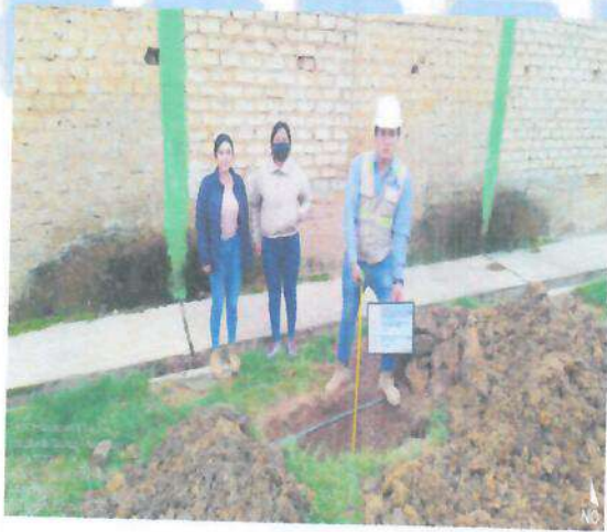
Fig.03: Excavación de calicatas en campo.
