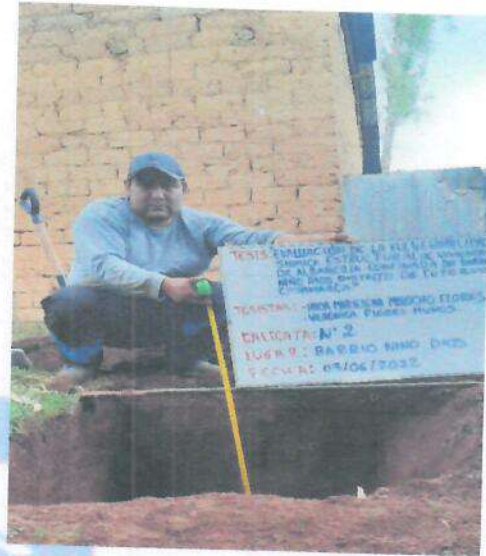
Fig.02: Excavación de calicatas en campo.
