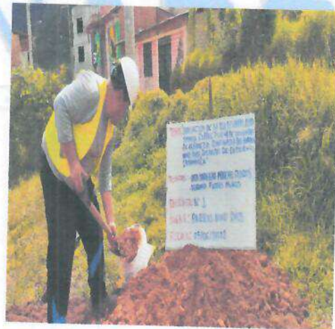
Fig.04: Excavación de calicatas en campo.
