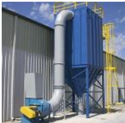
Figura 16. Extractor de polvos de una planta de granallado Fuente: Catálogo- TM Metal Corp.-Extractores de Polvos
