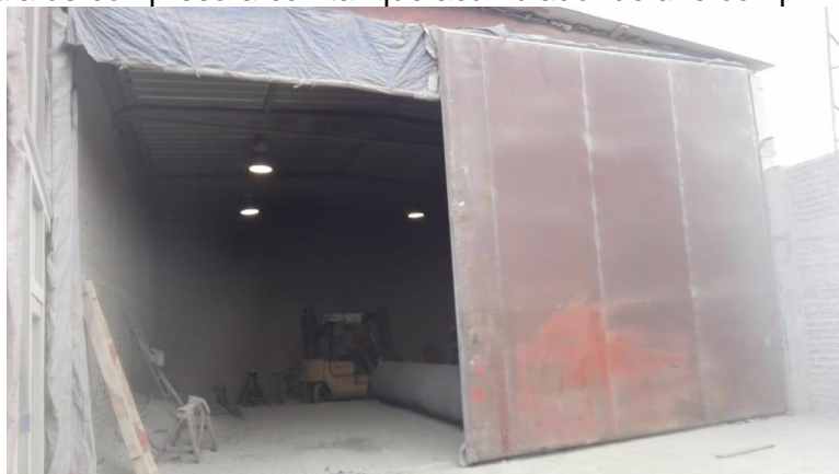
Cuarto o Cámara de arenado
