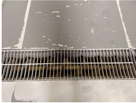
Transportador helicoidal para extracción de granalla utilizada en cuarto
