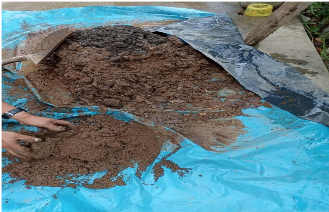
Fotografía N°14. Preparación del suelo humedecido para la fabricación del adobe.
