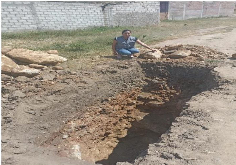
Fotografía N°05. Excavación del suelo para elección de material a utilizar.
