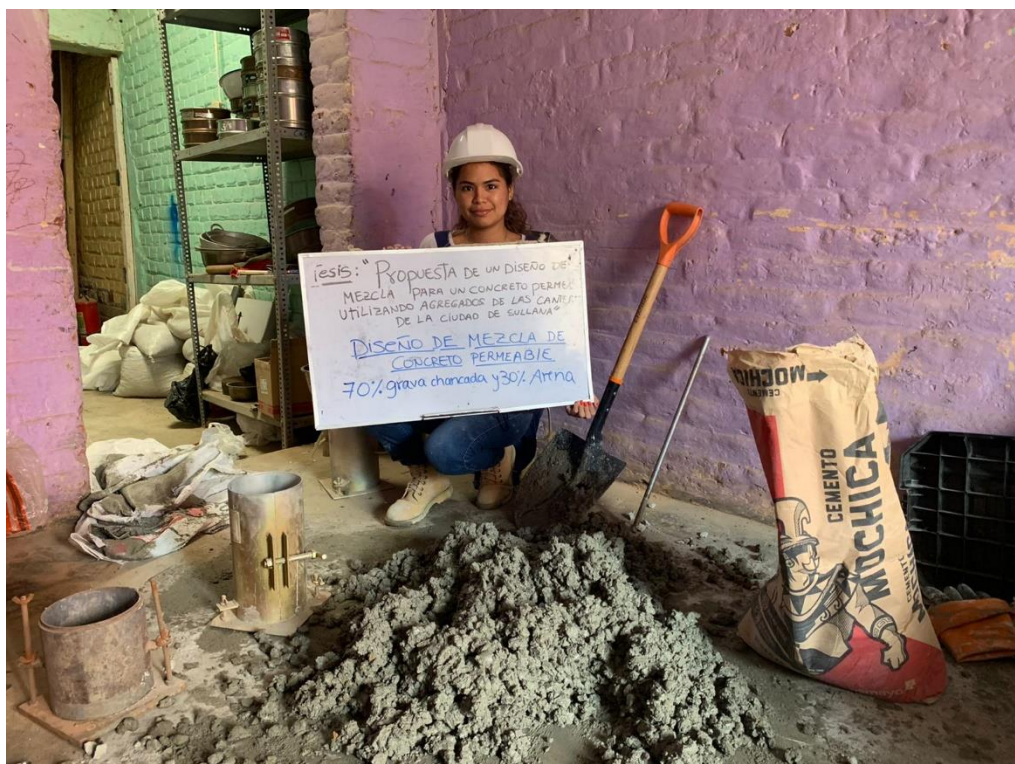
Mezclado de concreto.
