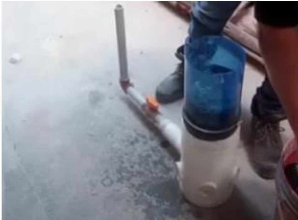
Ensayo de permeabilidad.
