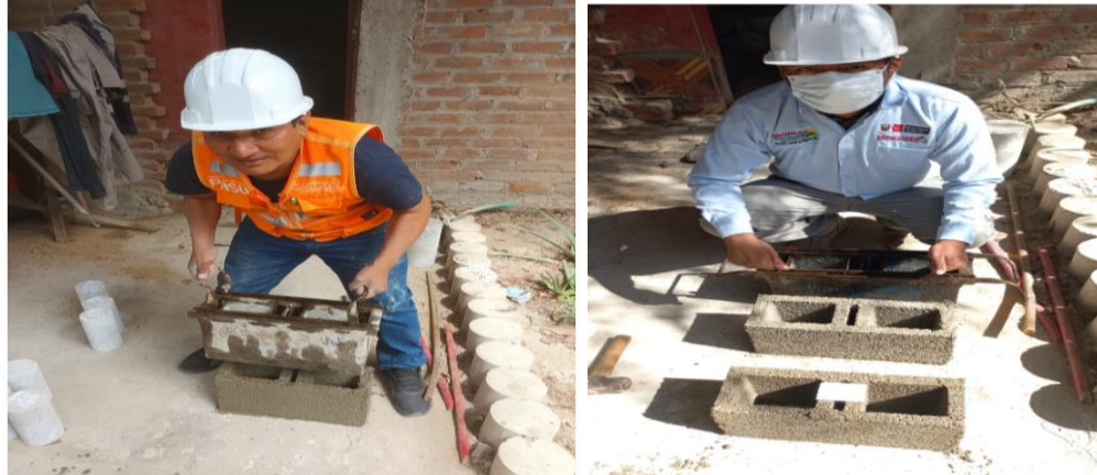
Figura 11. Elaboración del bloque de concreto.
