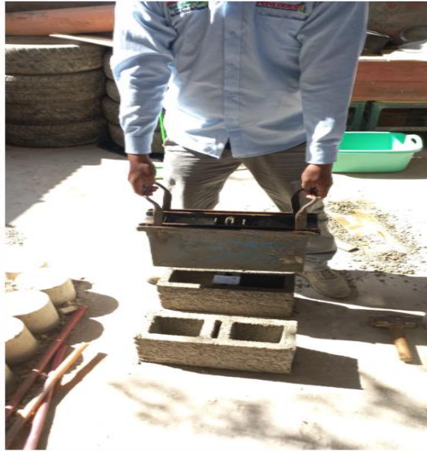
Elaboración de bloques de concreto
