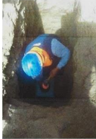
TOMA DE DENSIDAD CALICATA Nº 02, E-1
