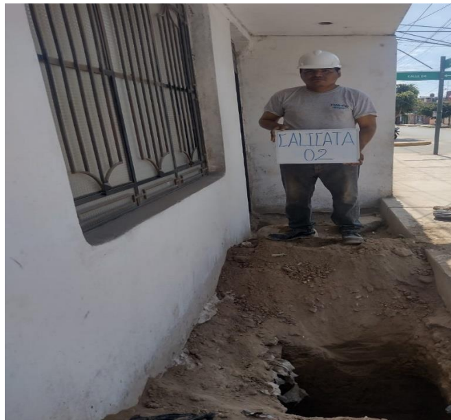
Figura 18. Calicata N° 2 Fuente: Elaboración Propia
