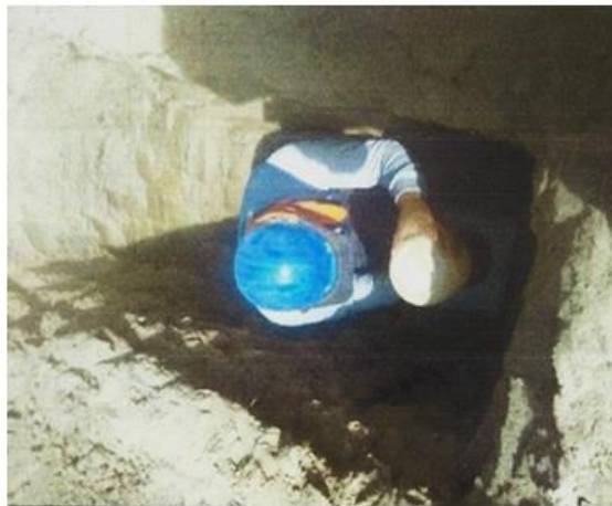
CALICATA Nº 02, E-1
