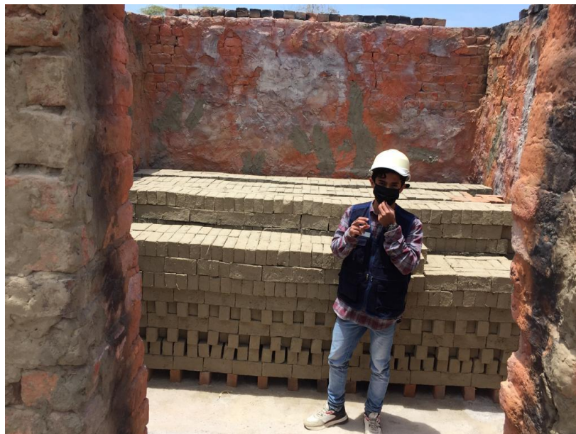
Figura 28. Ladrillos colocados en el horno
