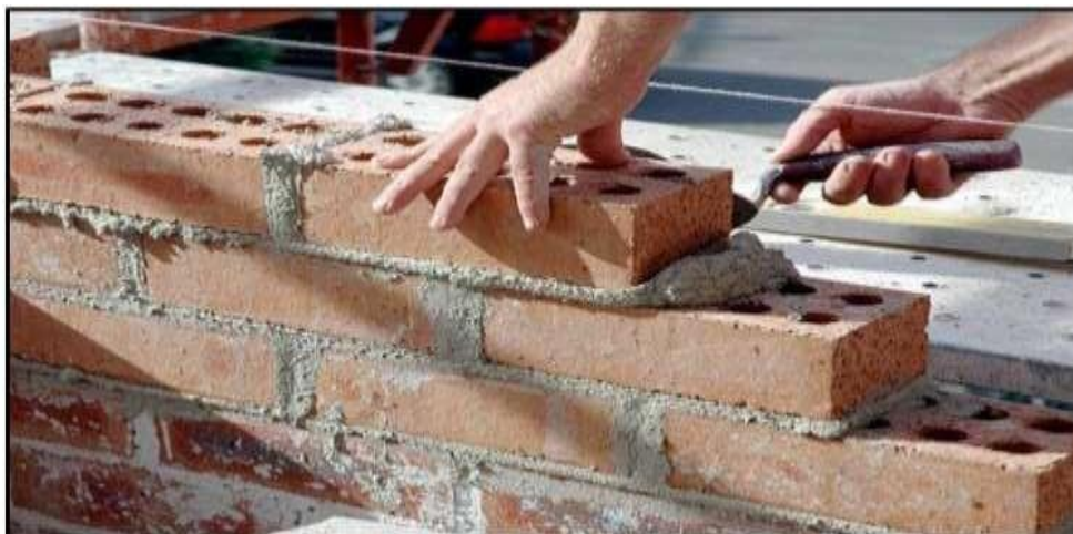
Figura 13. Unidades de Albañilería asentadas con mortero
