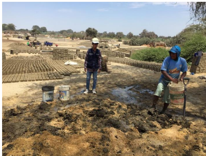
Figura 24. Mezcla para preparar el ladrillo
