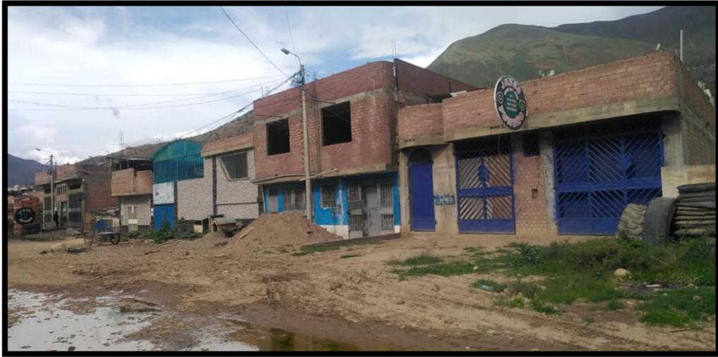
*Nota:* en la imagen se muestra la inexistencia de juntas sísmicas entre colindantes, también el desnivel entre techos terminados
