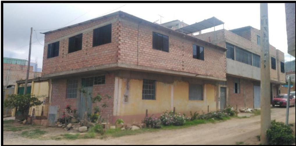
*Nota:* en la imagen se muestra muros del primer piso con ladrillo panderetas.
