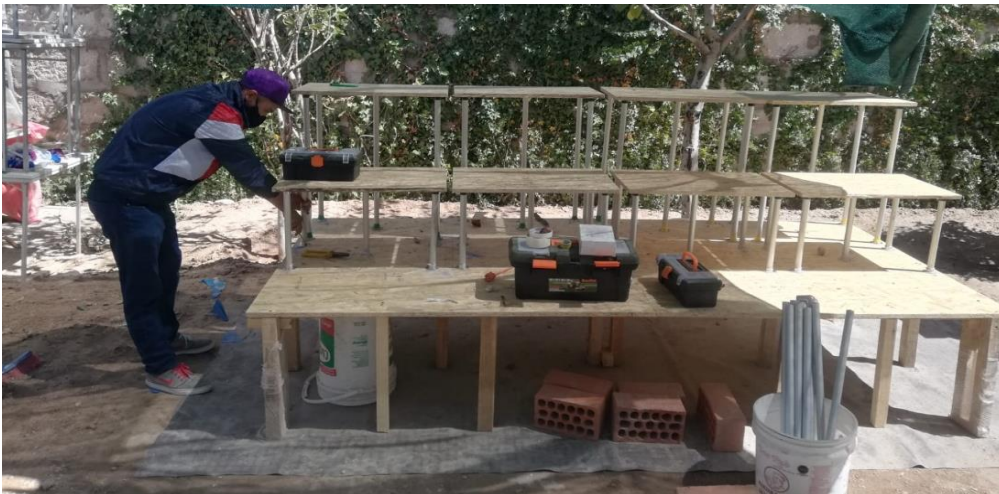
Figura 3. Soporte de OSB de 18 mm en tres niveles para contenedores del sistema de tratamiento mixto.
