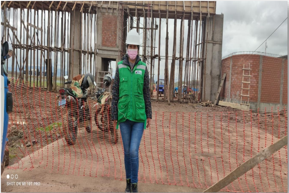
Fotografía 17: Inspección de trabajos en altura en acceso principal de la UNAJ.
