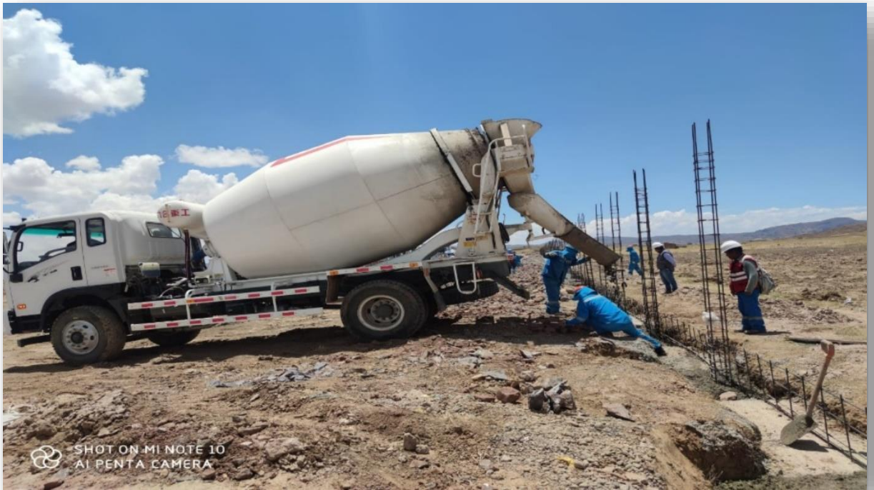
Fotografía 13: Inspección de áreas de trabajo “vaciado de concreto en sobrecimiento con mixer”. en el tramo A de la UNAJ
