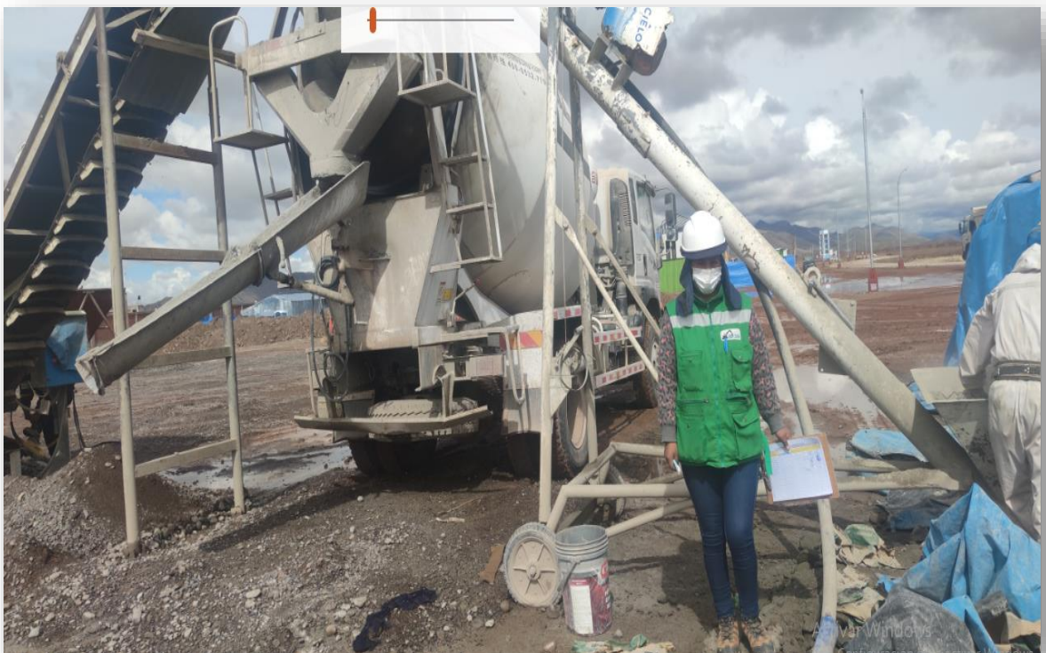
Fotografía 18: Inspección de área de trabajo “PLANTA CONCRETERA”, en el tramo A de la UNAJ
