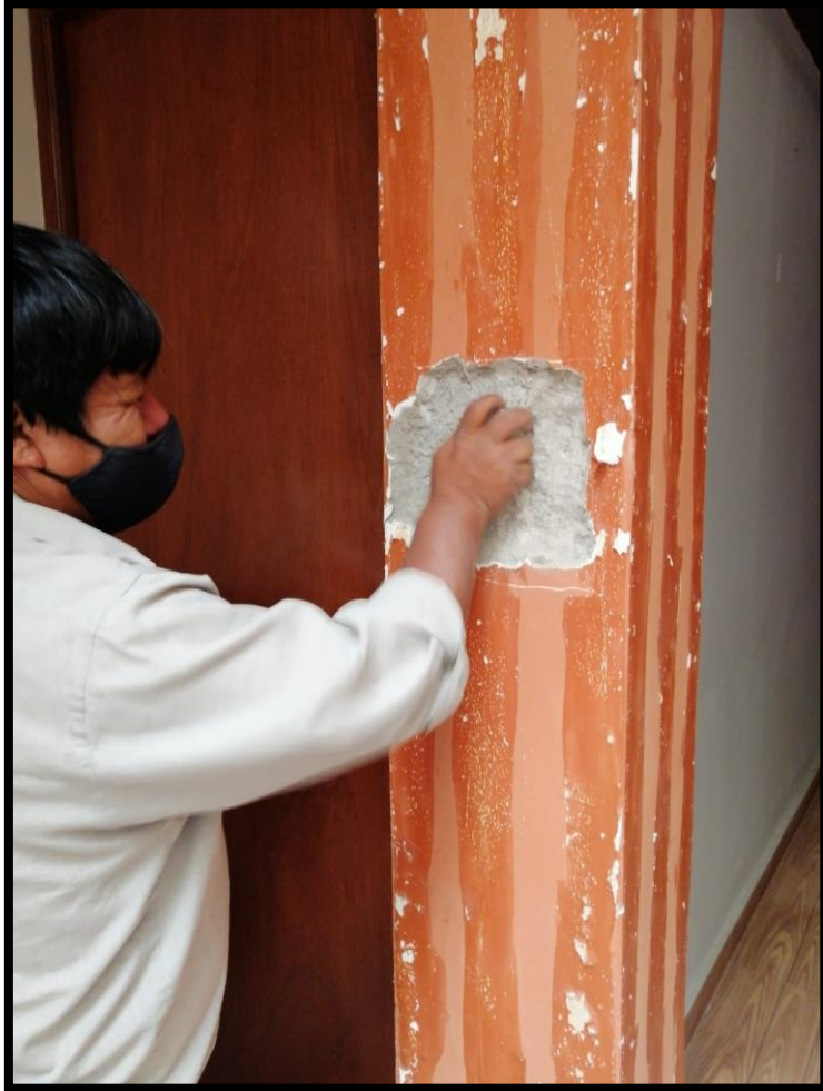
Anexo 6. ensayo de esclerómetro a columnas.
