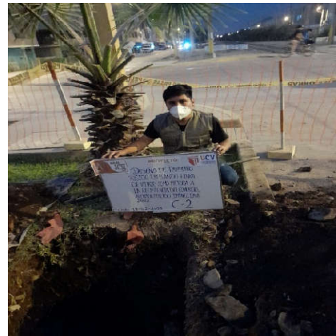
Figura 46. Excavación de calicatas en la Av. Plácido Jiménez
