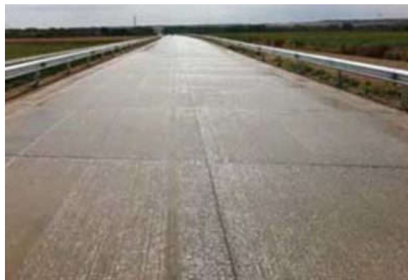
Figura 3. Pavimento empleando fibra de vidrio.
