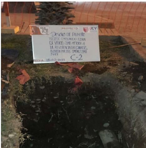
Figura 46. Excavación de calicatas en la Av. Plácido Jiménez
