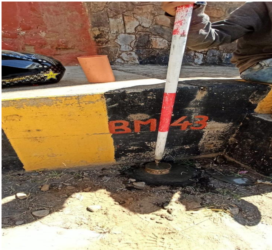
Anexo 6.6 Colocación de BM en un punto Fijo.
