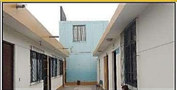
EL HALL DE ATENCIÓN EN EMERGENCIA, TIENE UN ANCHO DE 3.00ML, ESTO HACE QUE LA ACCESIBILIDAD A ESTE SERVICIO NO SEA LA ADECUADA.
