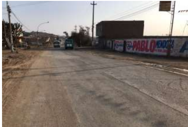
Panel 2. Realización de calicata C-02
