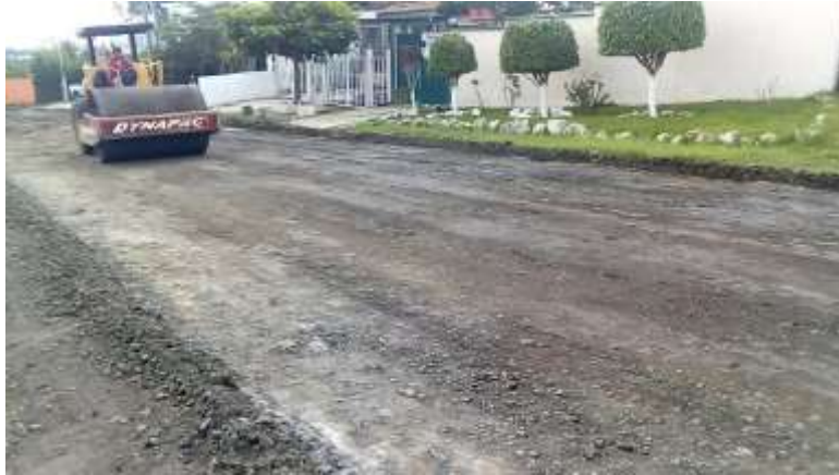
Figura 17. Compactación de la subrasante
