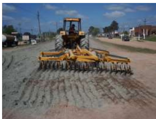
Figura 12. Mejoramiento de subrasante
