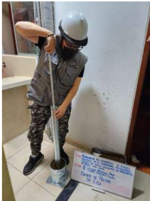
Figura 35. Compactación de suelos
