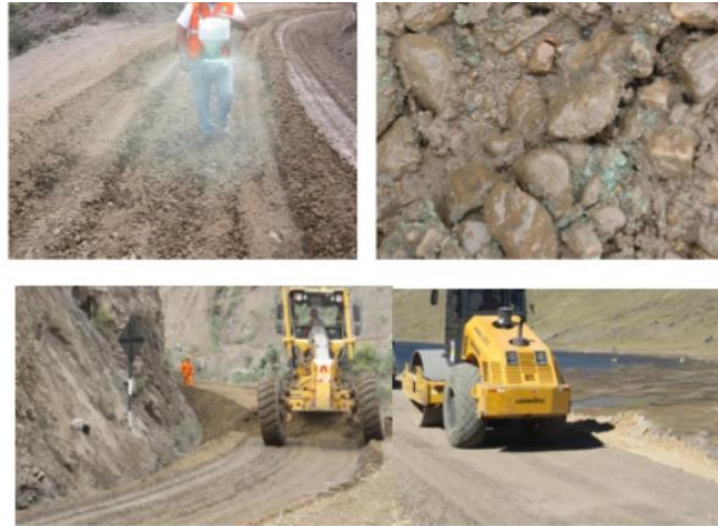
Figura 6. Distribución del aditivo Megasoil en campo
