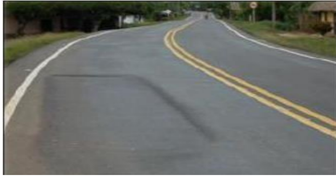
Figura 3. Depresiones o hundimientos longitudinales. Fuente: Instituto Nacional de vías (2008).
