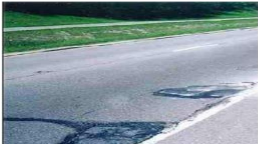
Figura 19. Afloramiento de mortero.
