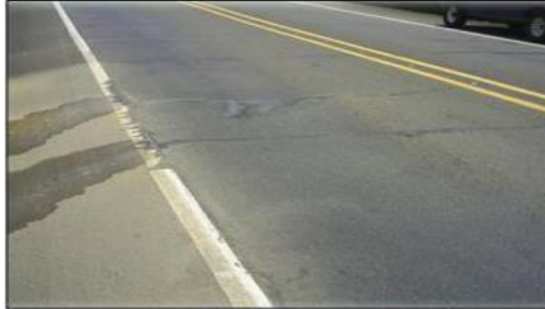
Figura 20. Afloramiento de agua. Fuente: Instituto Nacional de vías (2008).
