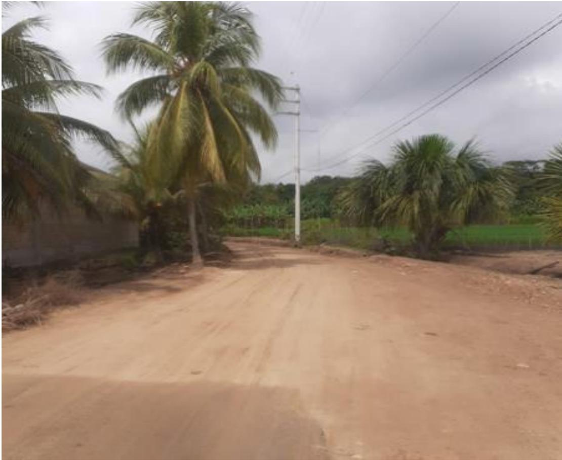
Se observa el ingreso al sector San Juan de Cumbaza, sin asfalto pero se encuentra en óptimas condiciones, el mantenimiento de la misma es permanentemente con el uso de maquinaria pesada. El ingreso tiene una pendiente pronunciada, asimismo en temporadas de lluvias muestra un grado de deterioro.
