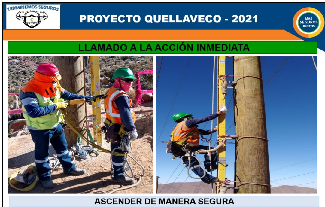
Figura 37: Supervisor HSE realizando acciones preventivas, previos a los trabajos en altura
