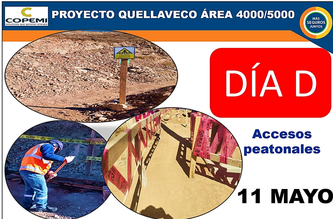
Figura 82: Eliminación de obstáculos de los accesos peatonales en las áreas de trabajo.
