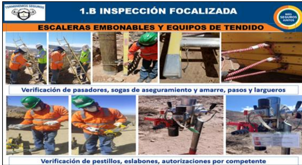
Figura 90: Inspección focalizada en verificar las escaleras embonables, sogas, tecles ratchet, tarjetas de autorización del personal competente para operar equipos, entre otros.
