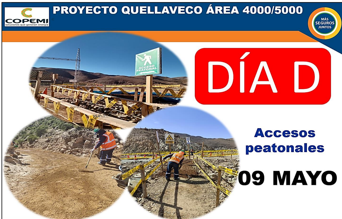
Figura 80: Implementación de accesos peatonales seguros en las áreas de trabajo
