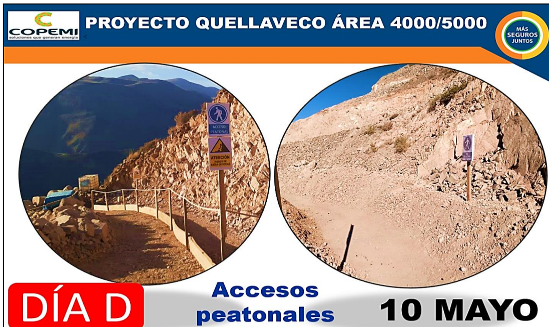
Figura 81: Señalización de los accesos peatonales en las áreas de trabajo.
