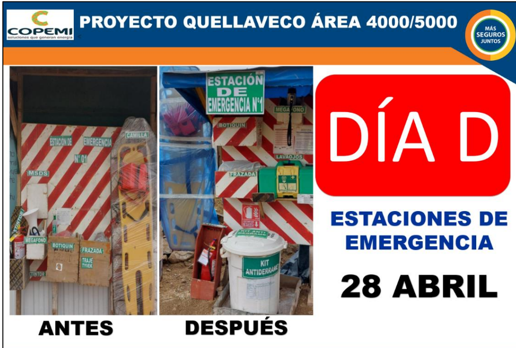
Figura 54: Estación de Emergencia antes, y después de la implementación
