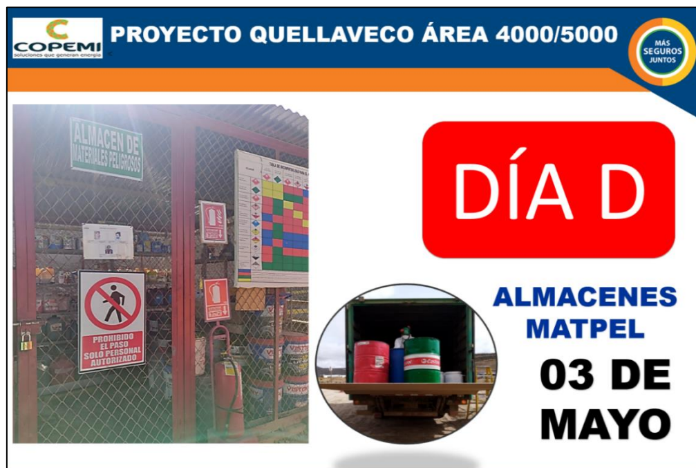
Figura 57: Implementación de señalética informativa y prohibición en el almacén Matpel.
