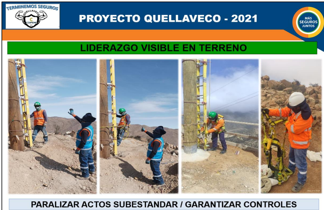
Figura 38: Supervisor electromecánico y Capataz demostrando liderazgo en campo.
