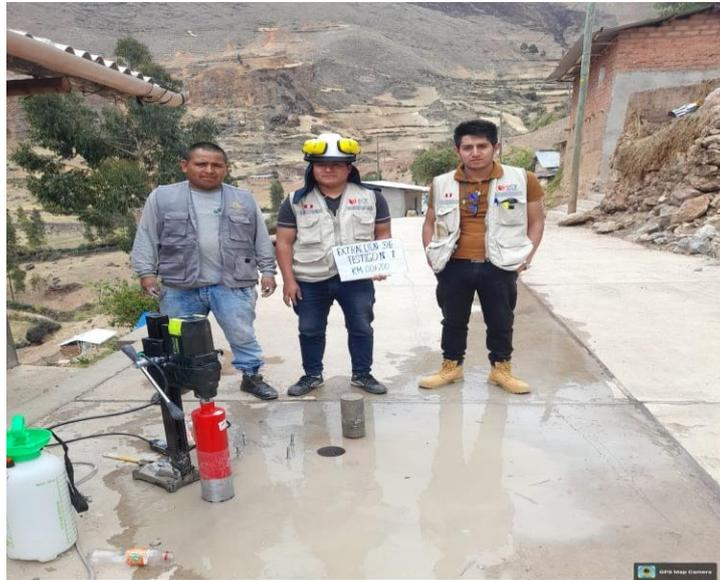
**Figura 21.** *Extracción de testigos.*
