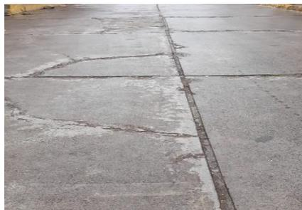
**Figura 13.** *Losa dividida.*
