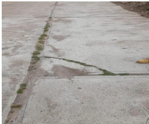
**Figura 15.** Deterioro de sello de junta de mediana severidad.
