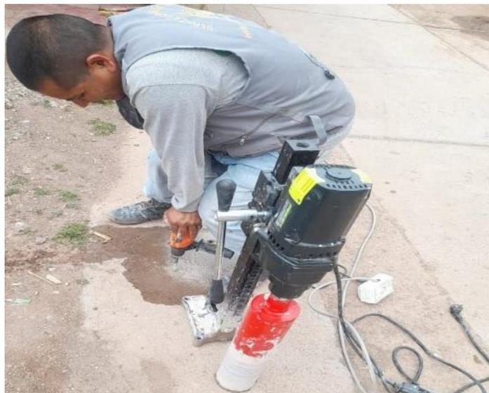
**Figura 22.** *Perforación del pavimento para la estabilización del equipo.*
