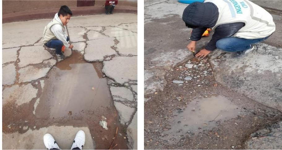
**Figura 16.** *Desnivel de carril / berma con alta severidad.*
