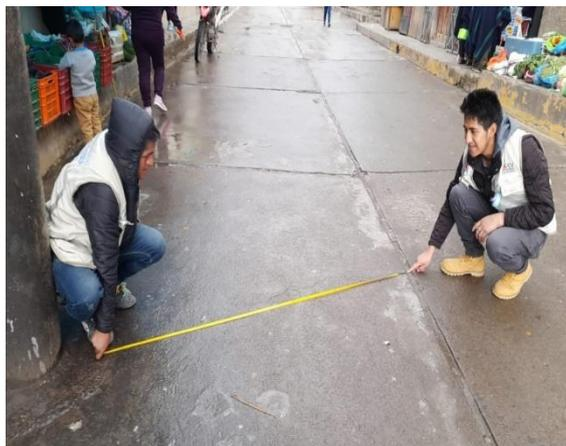
**Figura 17.** *Grietas lineales de severidad mediana.*
