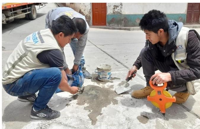
**Figura 24.** Sellado de puntos de extracción.
