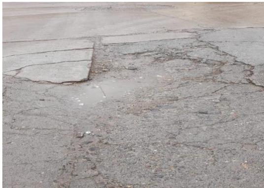
**Figura 10.** *Fallas en el pavimento.*
