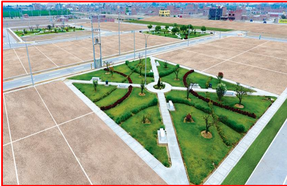
Figura N° 3: Vista del Terreno que se diseñara la edificación. De perfil de un Drone. Fuente: Propia.
