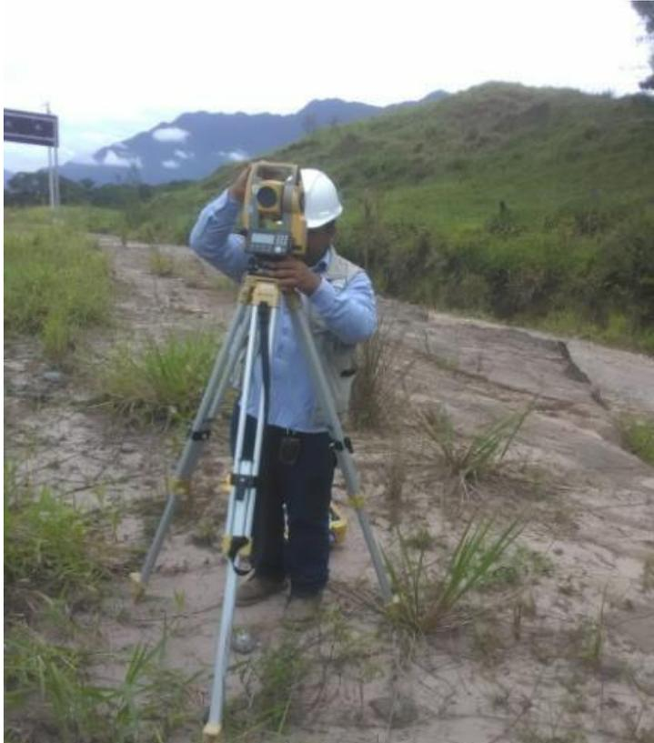
**FOTO N°5: TOMANDO LECTURA DE ELEVACIÓN DEL BM2 AL BM1.**
