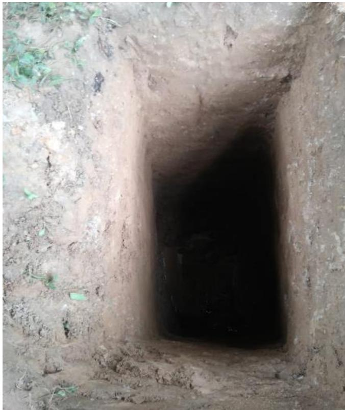
**FOTO N°10: CALICATA CON UNA PROFUNDIDAD DE 3M SE PUEDE APRECIAR FILTRACIÓN DE AGUA.**
