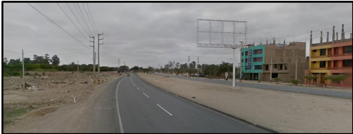
Figura 20. Vía de acceso principal – Av. Los Maestros
