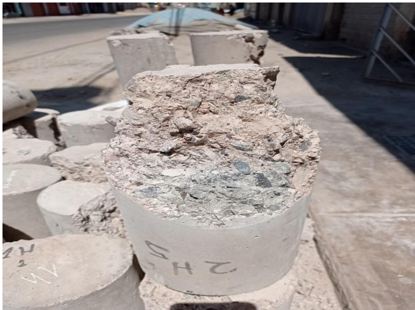
Fotografía 20. Daños físico internos del concreto
