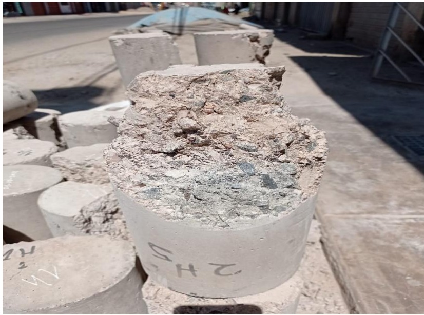
Fotografía 19. Daños físico internos del concreto
