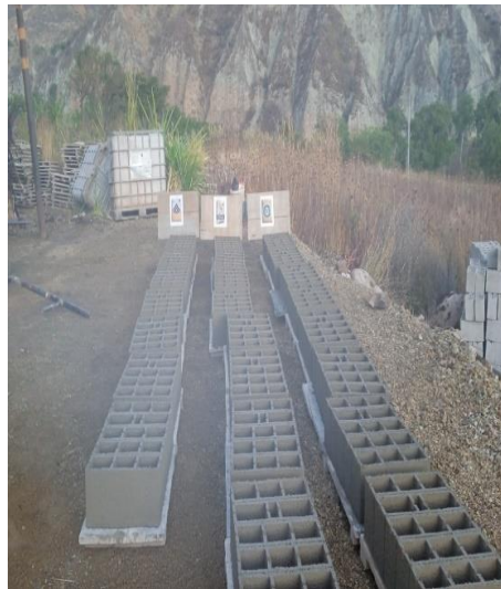
Foto 16 Secado de bloquetas,40 unidades por cada tipo de cemento (0.12.0X20.0X0.440M)
