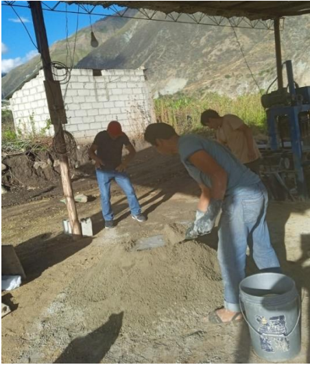
Foto10 incorporación de agua(trabajable)
