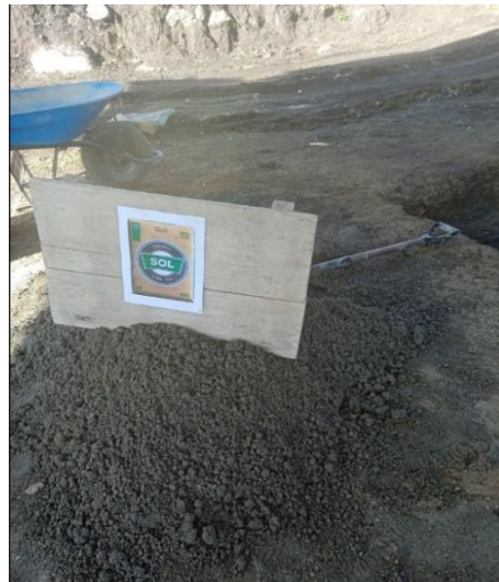
Foto 05 dosificación cemento Sol
