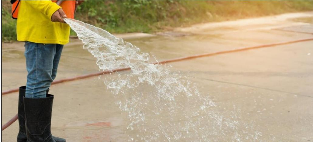
*Figura 17:* Riego de agua sobre la superficie de concreto
