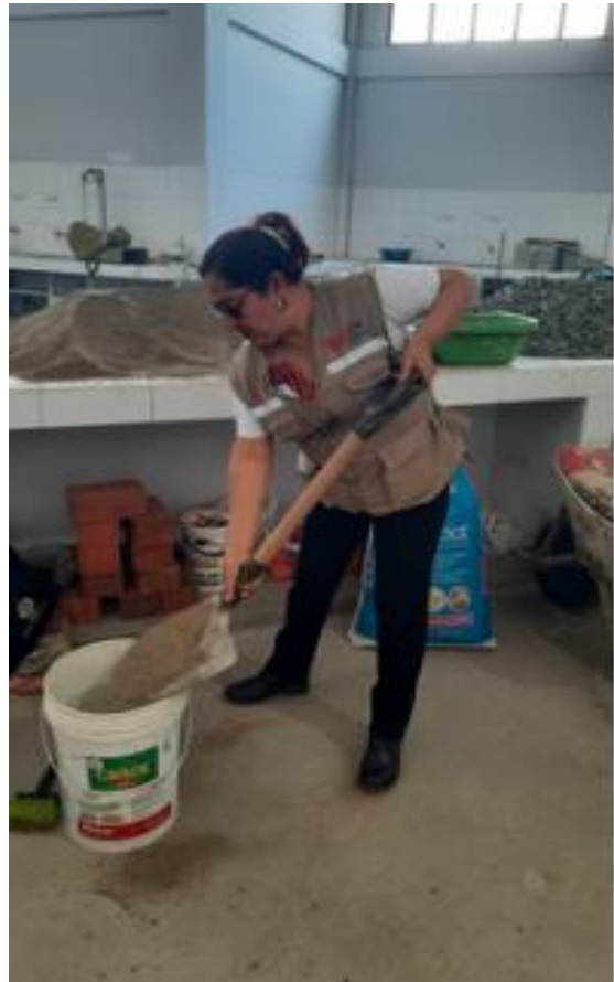
Figura 13. dosificación de los materiales
