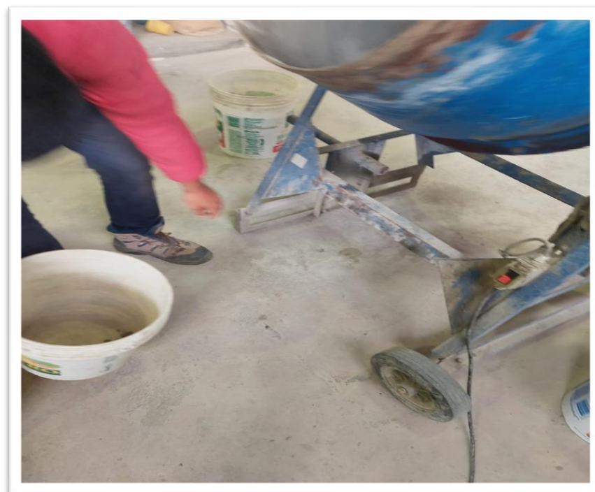
Figura 17. Incorporación de agua según diseño de mezcla.
