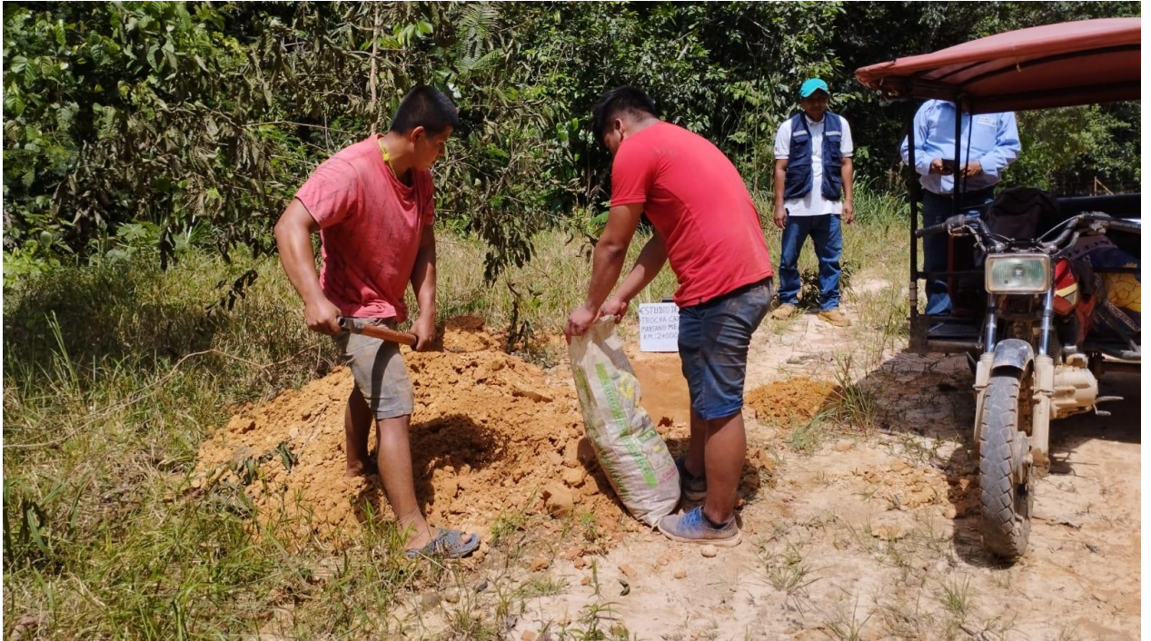
Ilustración 105, Calicata N°03 progresiva 2+000 elaboración propia.
