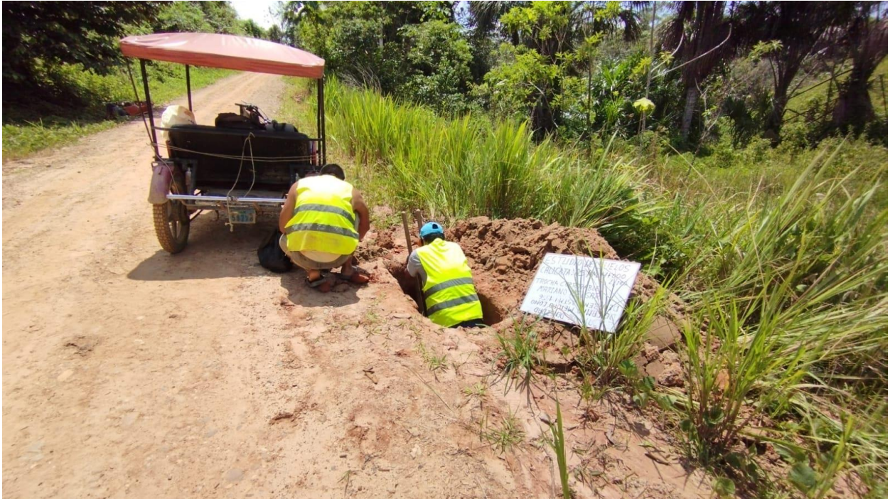
Ilustración 109, Calicata N°05 progresiva 4+000 elaboración propia.
