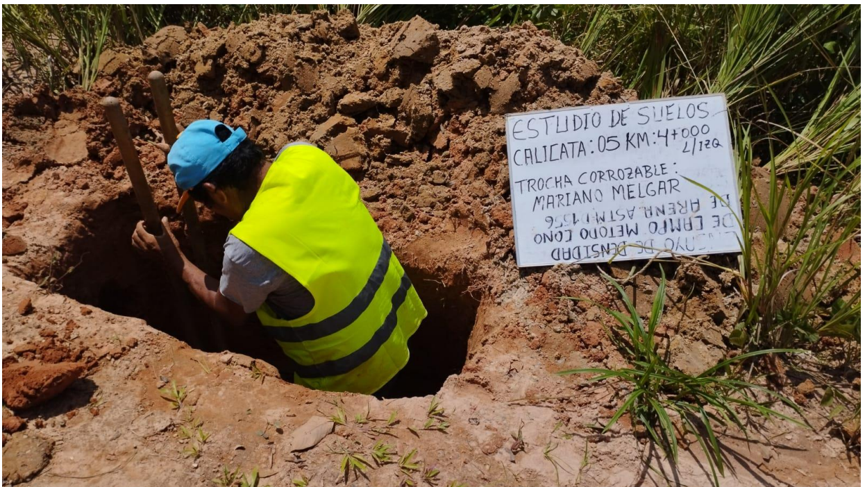
Ilustración 108, Calicata N°05 progresiva 4+000 elaboración propia.
