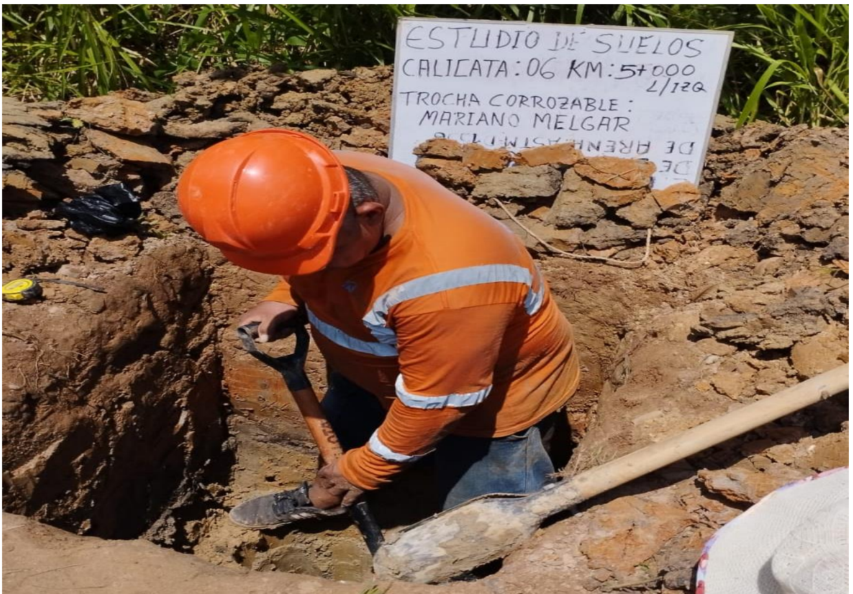
Ilustración 110, Calicata N°06 progresiva 5+000 elaboración propia.
