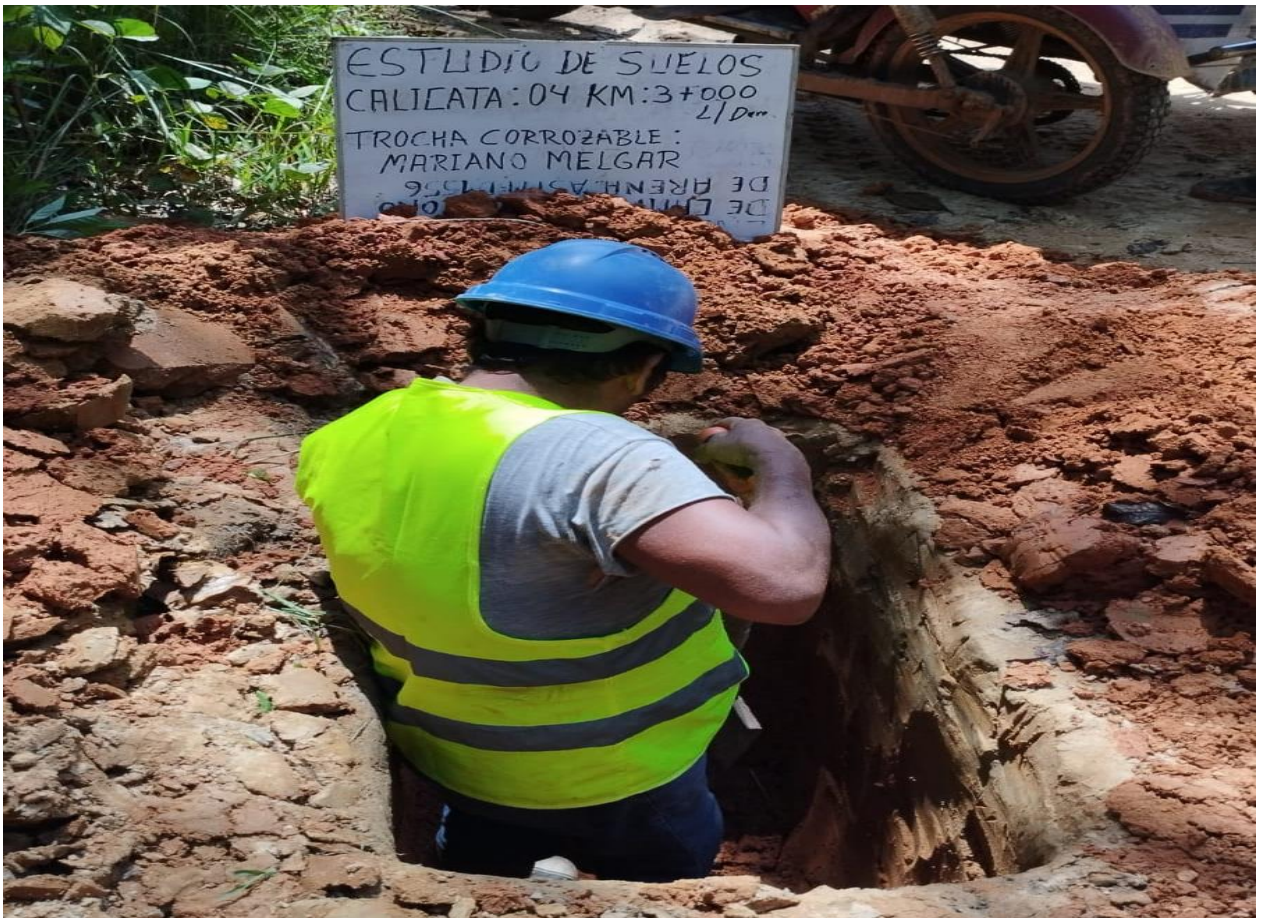
Ilustración 106, Calicata N°04 progresiva 3+000 elaboración propia.
