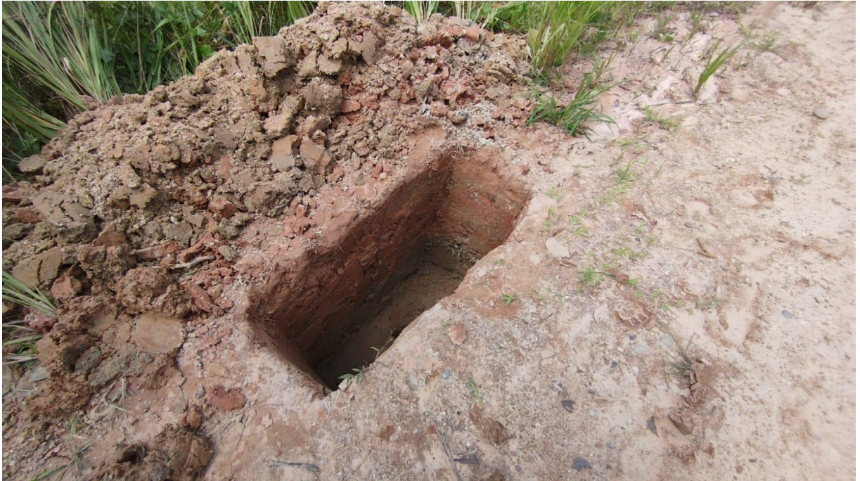
Ilustración 111, Calicata N°06 progresiva 6+000 elaboración propia.
