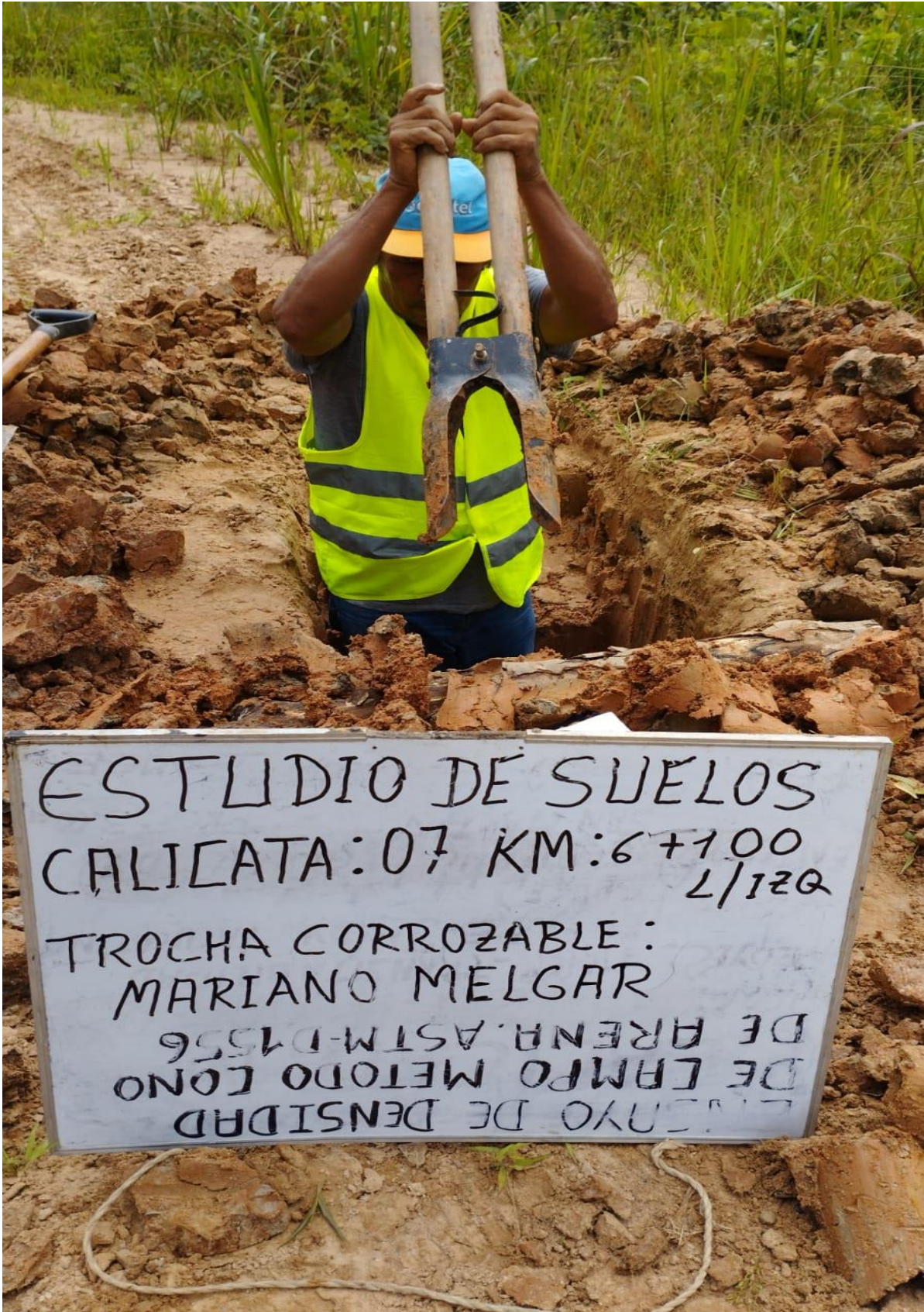
Ilustración 113, Calicata N°07 progresiva 6+100 elaboración propia.
