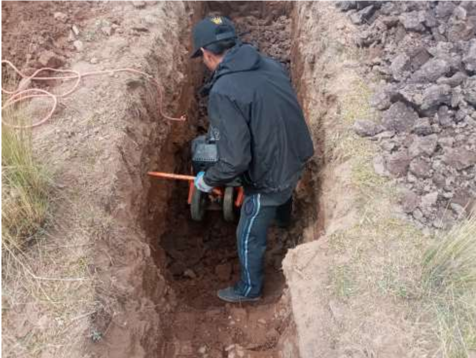
Fotografía 69. Compactación del suelo para la colocación de geomallas biaxiales
