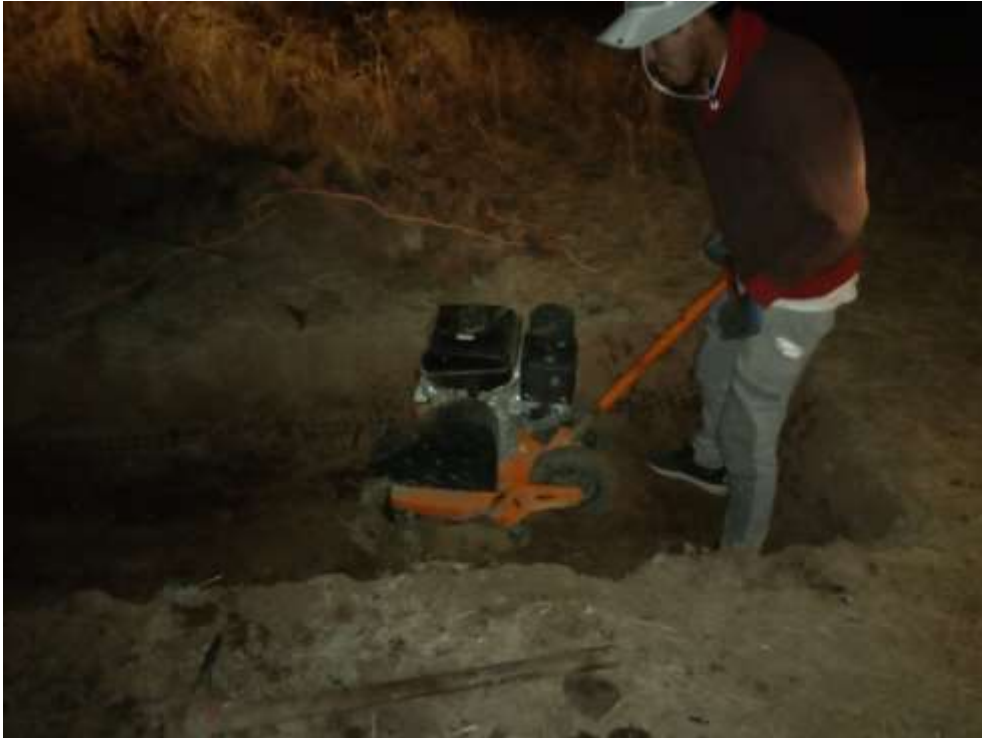
Fotografía 71. Relleno y compactación del suelo con las geomallas biaxiales
