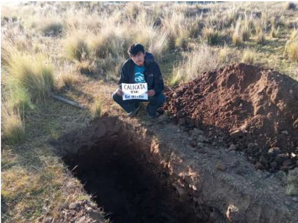
Fotografía 8. Excavación de la calicata N°08
