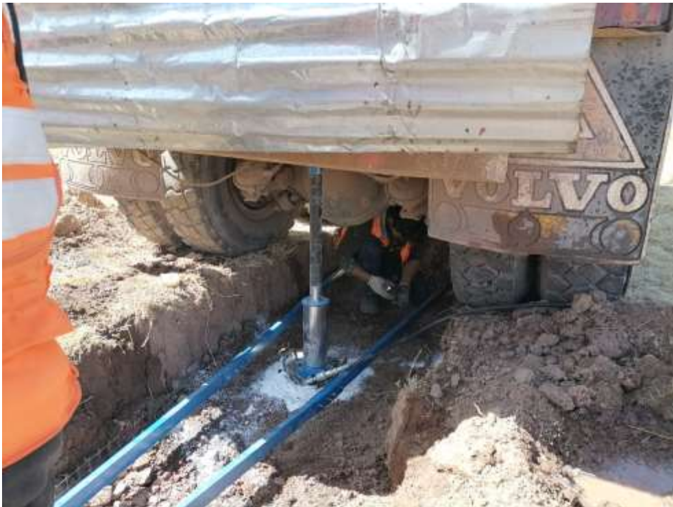
Fotografía 76. Revisión de la verticalidad
