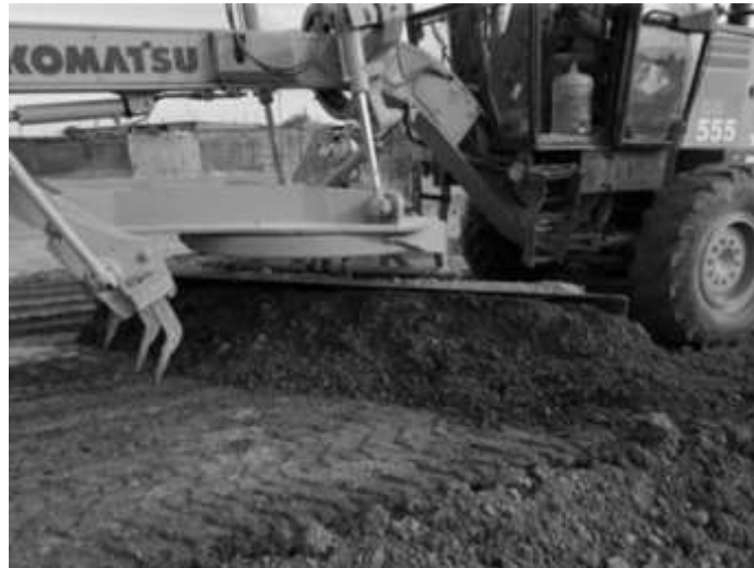
Figura 5. Perfilado del material estabilizado
