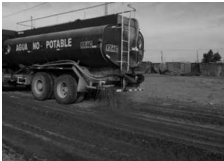
Figura 4. Mezcla del Consolid (NLF) con cisterna
