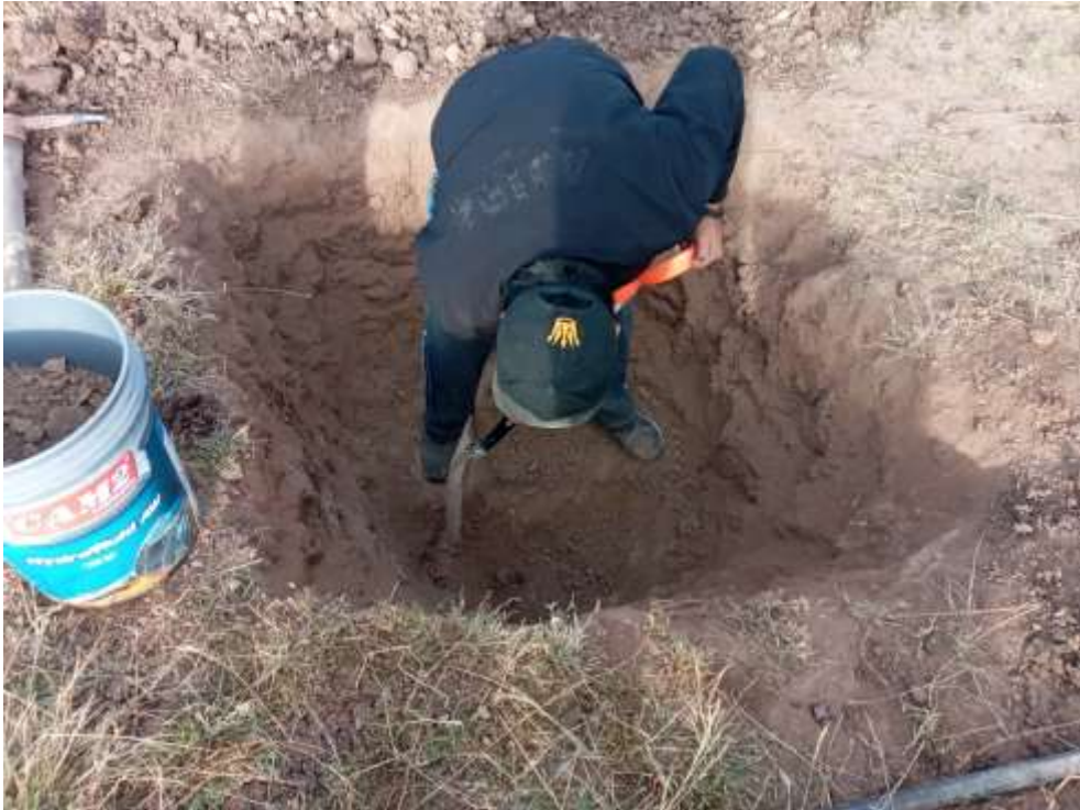
Fotografía 5. Excavación de calicatas de forma manual
