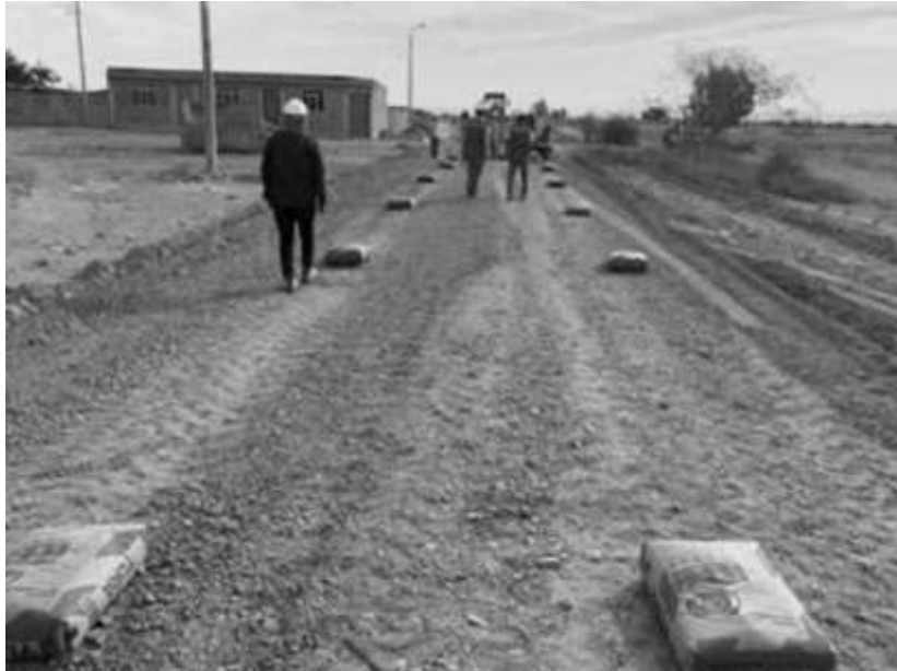
Figura 1. Colocación de las bolsas de aditivo aglomerante
