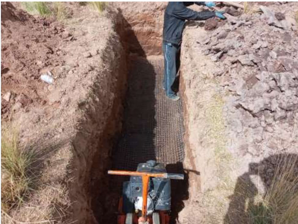
Fotografía 70. Colocación de las geomallas biaxiales a nivel de subrasante
