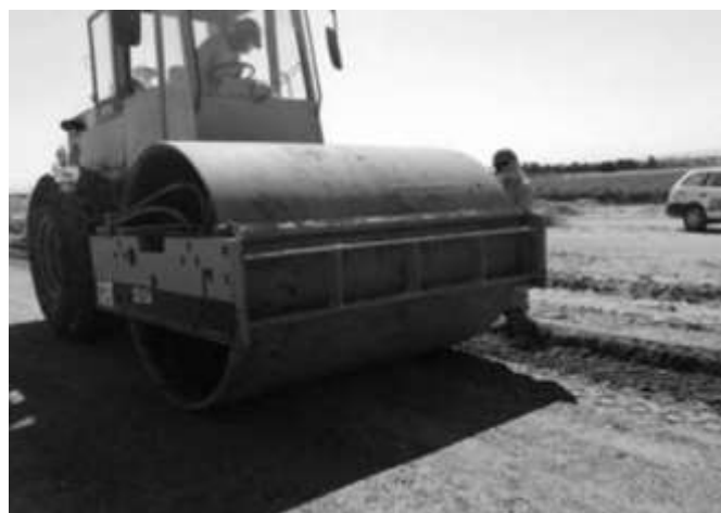
Figura 6. Compactación del material estabilizado
