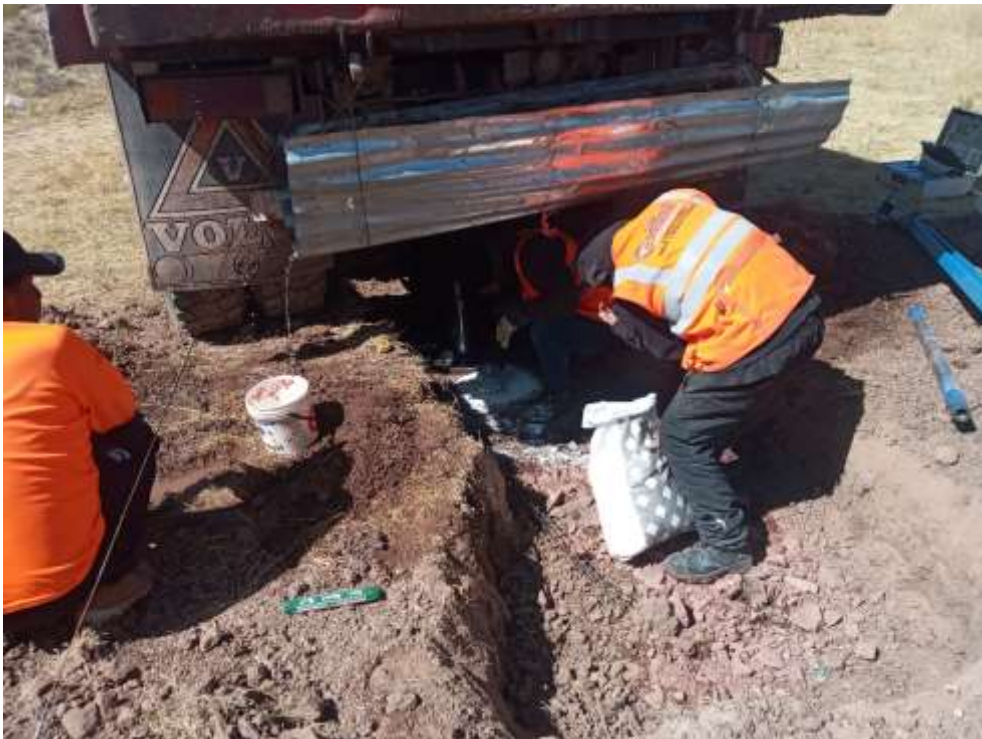
Fotografía 74. Preparación de la superficie y nivelación de la placa
