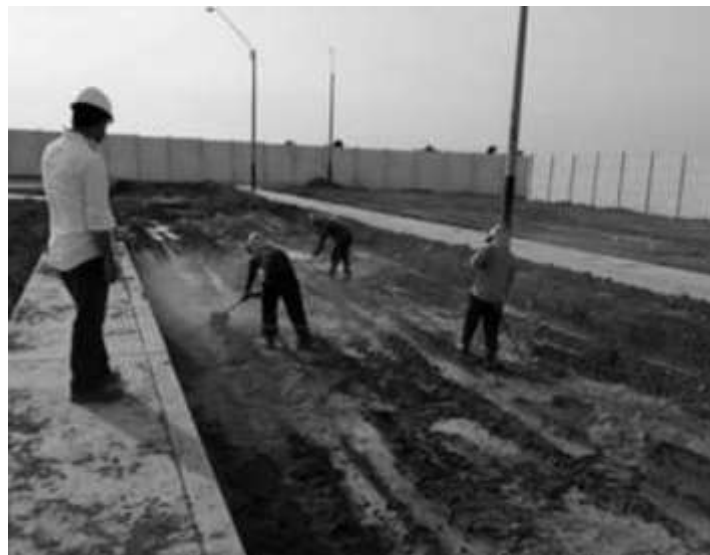
Figura 2. Distribución del aglomerante en la vía
