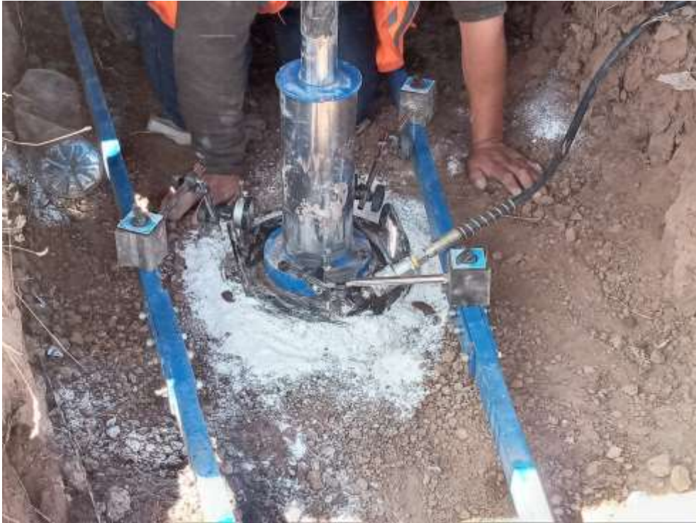
Fotografía 75. Colocación de los comparadores, barras y gata hidráulica
