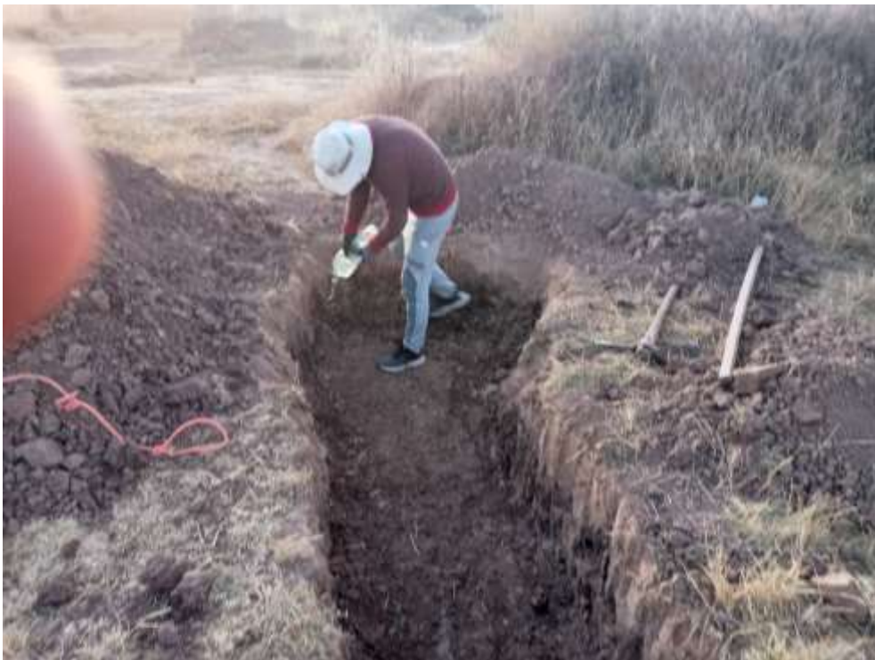
Fotografía 68. Humectación del suelo para su compactación
