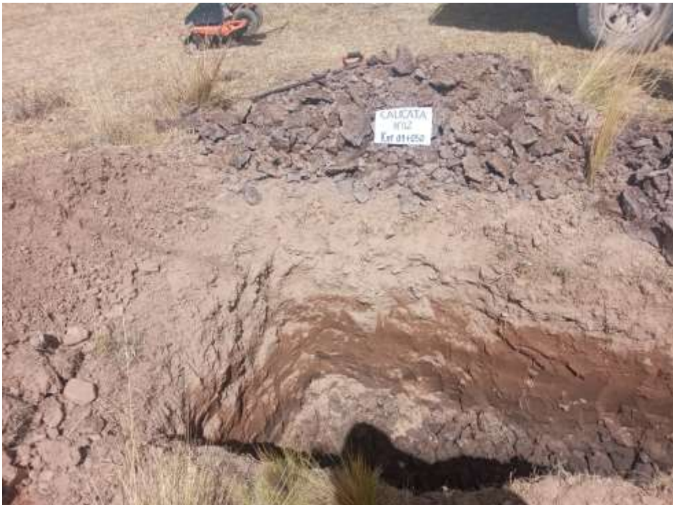
Fotografía 6. Excavación de la calicata N°02
