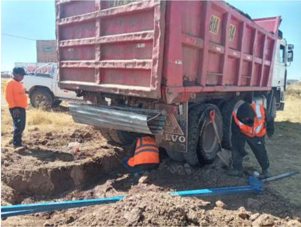
Fotografía 73. Ubicación del camión en los puntos con geomallas
