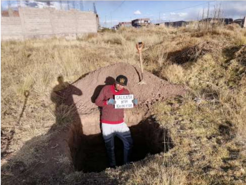
Fotografía 7. Excavación de la calicata N°04
