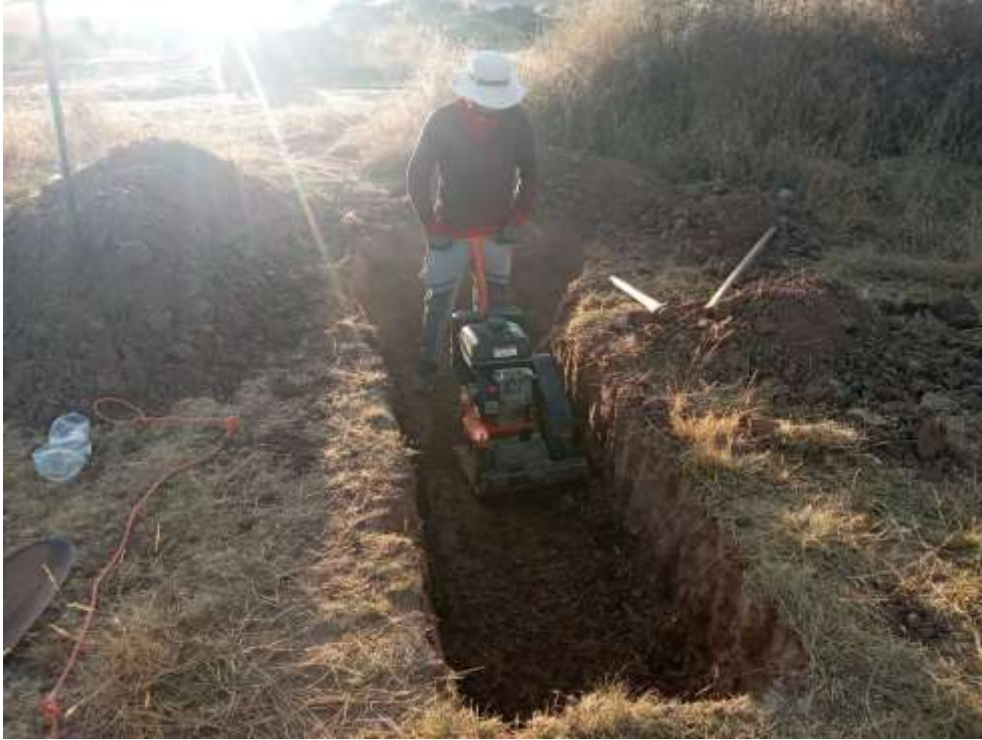
Fotografía 67. Compactación de las calicatas de forma manual
