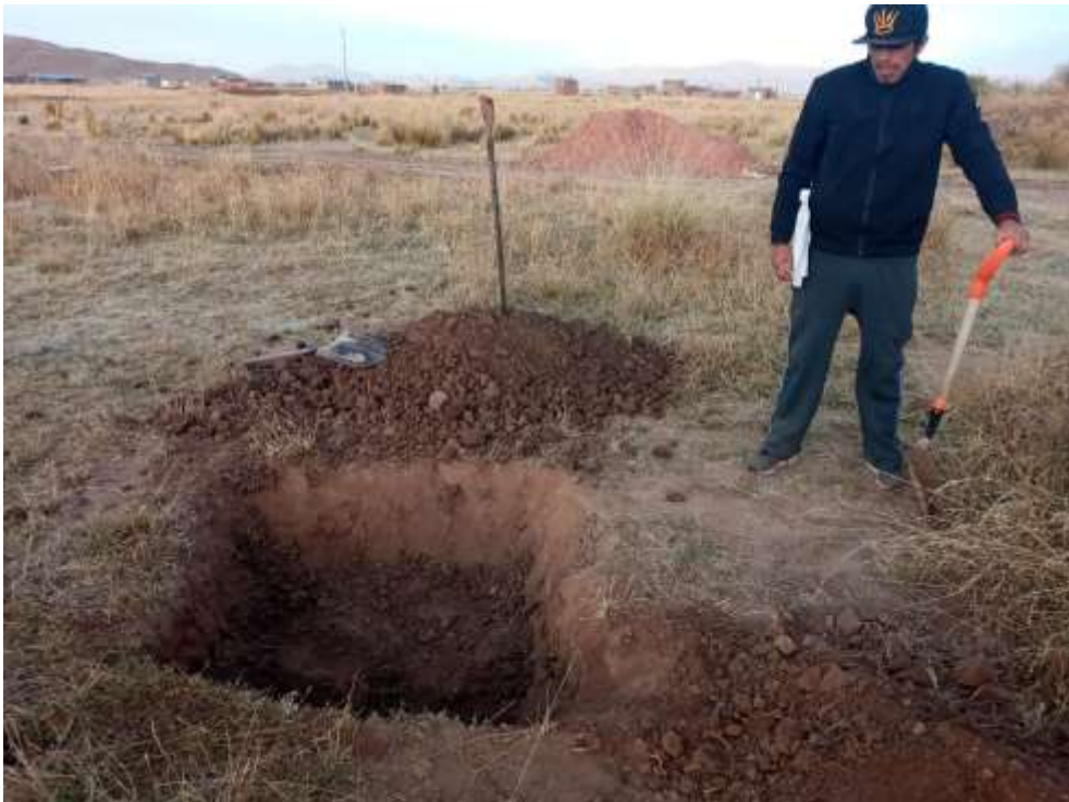
Fotografía 4. Excavación de calicatas
