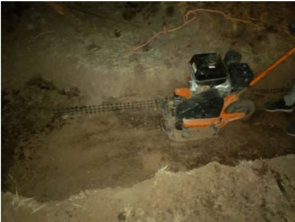
Fotografía 72. Compactación del suelo con las geomallas biaxiales
