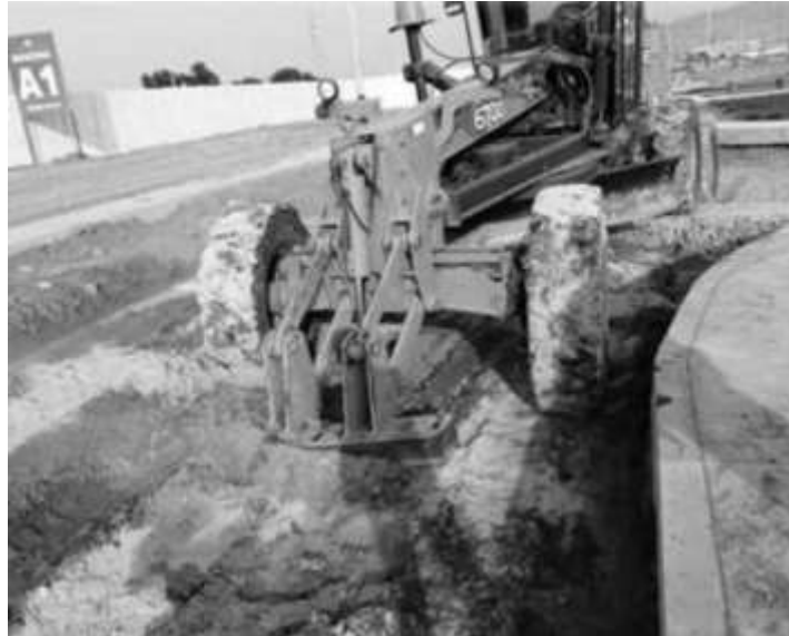
Figura 3. Escarificación del material con el aglomerante
