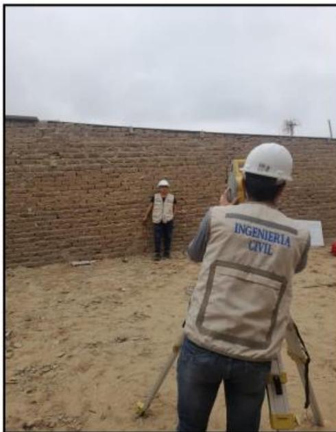
N°3. Obteniendo datos de los puntos en el perímetro del terreno
