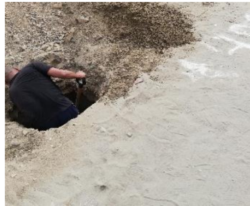
Foto 6: Excavación de calicata 3
