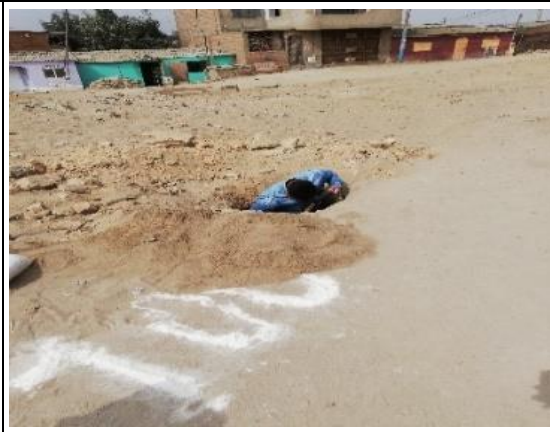
Foto 2: Excavación de calicata 1
