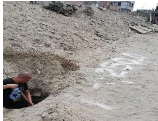
Foto 4: Excavación de calicata 2
