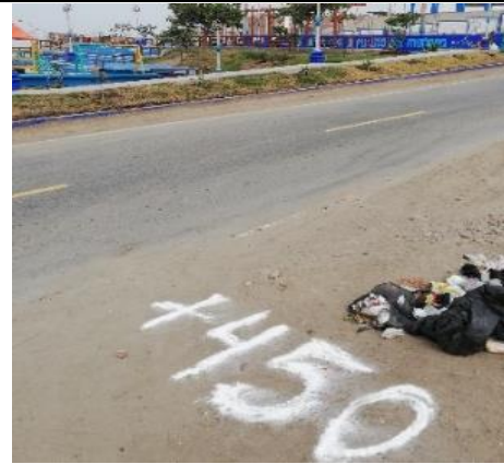
Foto 8: Vía en el punto 450m
