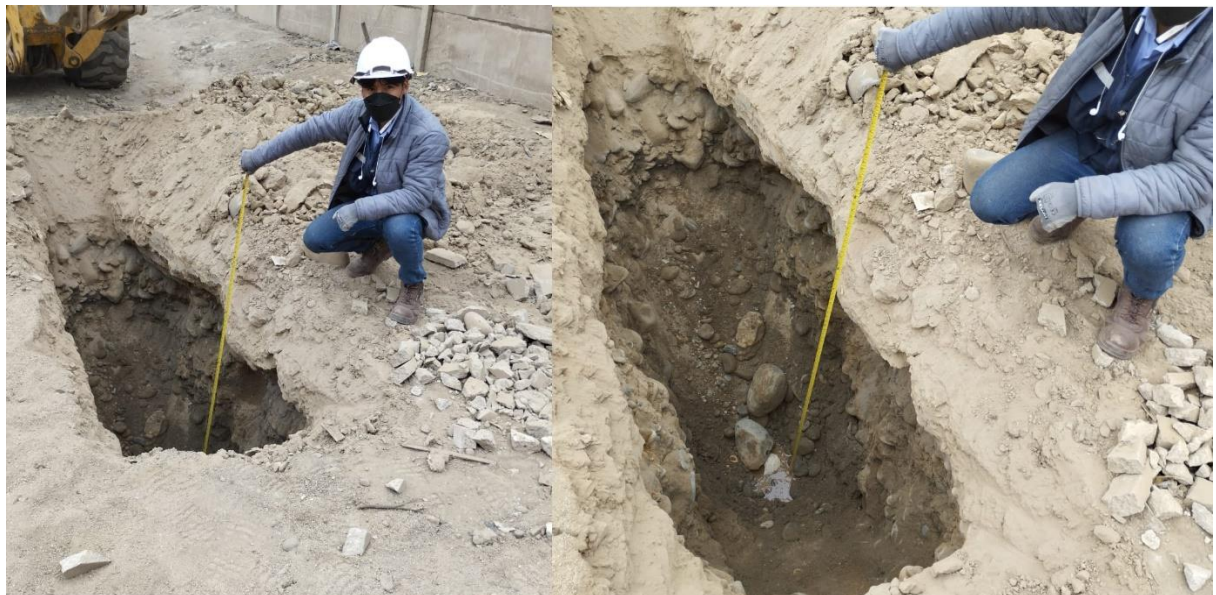
Figura 202 Registro de presencia de napa freática a profundidad 2,10m de la C-3.
