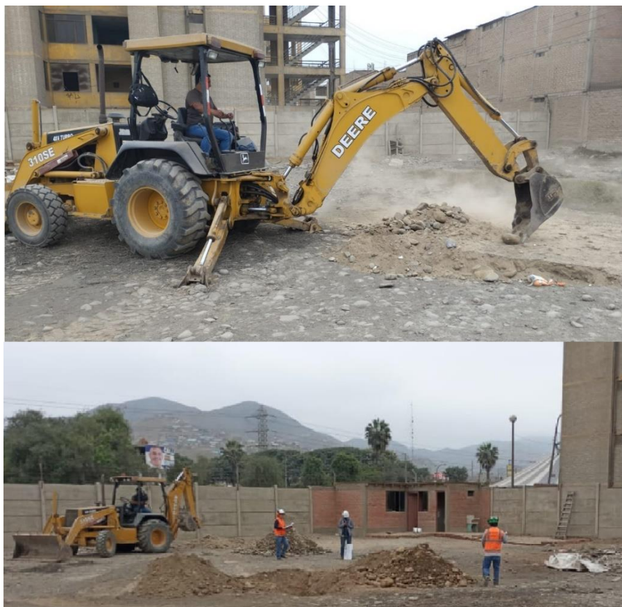
Figura 196 Inicio de excavación de calicatas bajo supervisión de especialistas.
