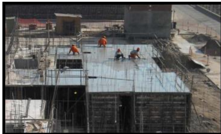
Figura 12 Vaciado de losa de sistema MDL.
