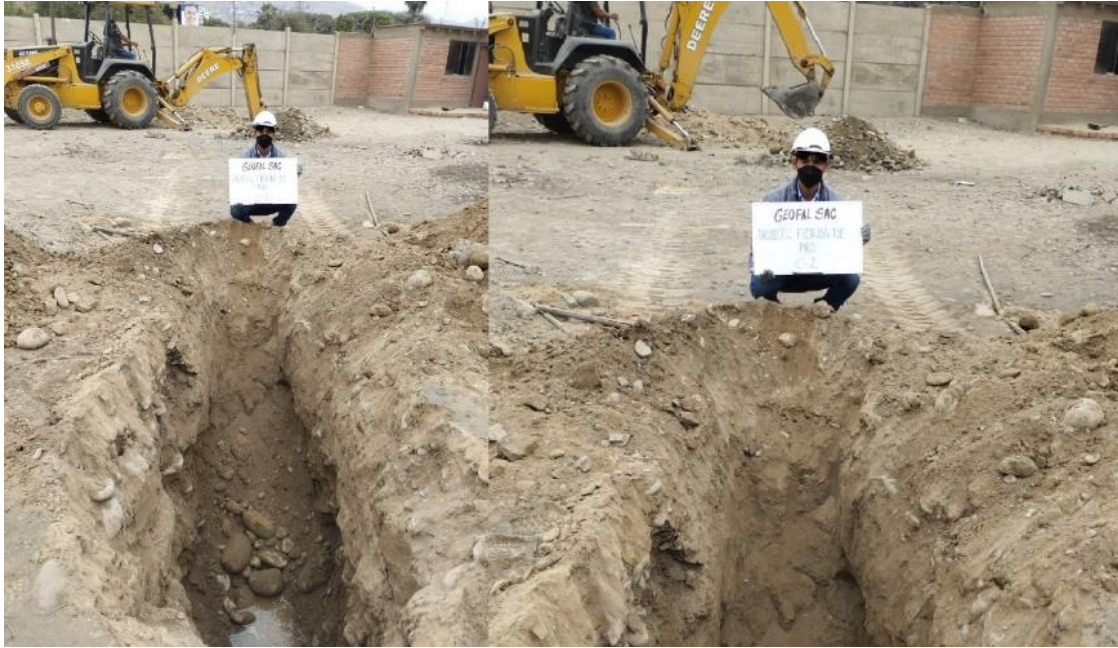
Figura 27 Registro de presencia de calicata de nombre C-2.
