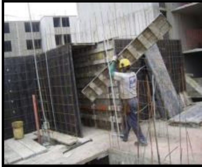
Figura 11 Encofrado de muros de ductilidad limitada.
