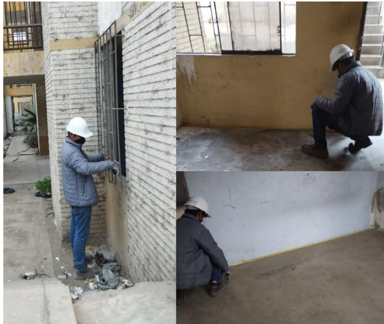
Figura 193 Toma de medidas para levantamiento de plano arquitectónico.
