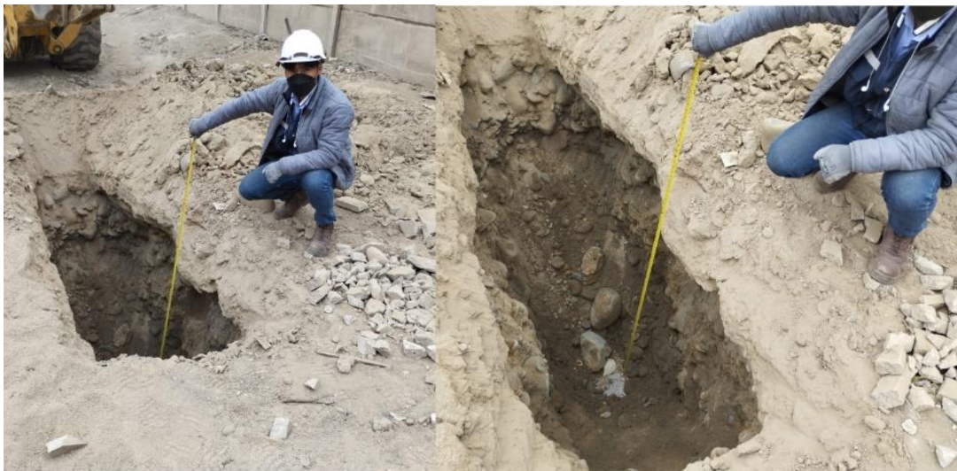
Figura 30 Registro de presencia de napa freática a profundidad 2,10m de la C-3.
