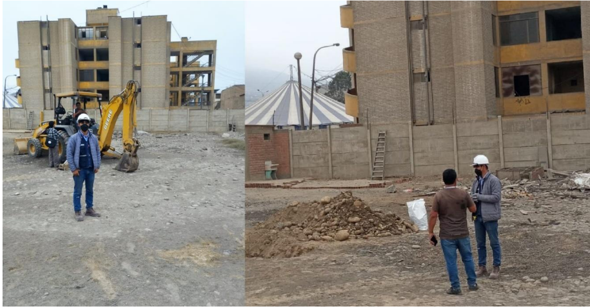
Figura 195 Coordinación y ubicación de puntos de exploración in situ.
