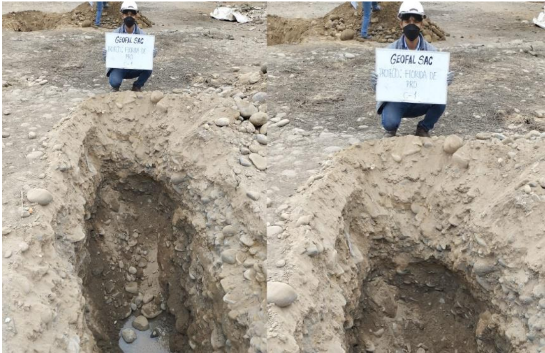
Figura 25 Registro de presencia de calicata de nombre C-1.
