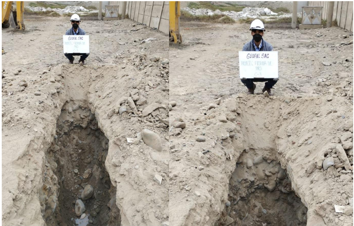
Figura 201 Registro de presencia de calicata de nombre C-3.
