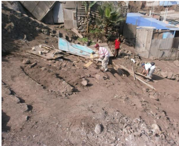
Imagen 80: Las escaleras del AA.HH Eden del Manantial.
