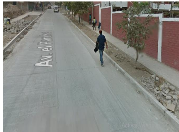
Imagen 67: Pistas y veredas en la A.V El Paraíso al costado del colegio “Paraíso N°7220”.
