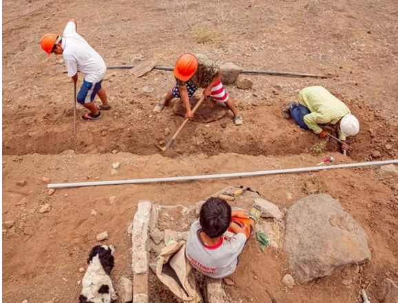
Imagen 13: Mantenimiento de las sequías en época de verano por parte de los jóvenes voluntarios, utilizado herramientas como pico, pala, tuvo, entre otros.
