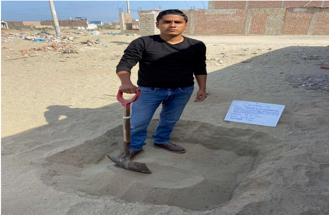
Realización de calicata 1
