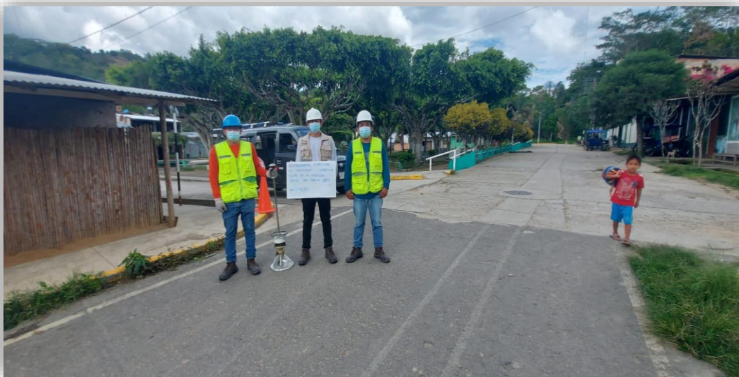
Figura N°19: Final en el km 17+040 – Plaza de San Roque de Cumbaza
