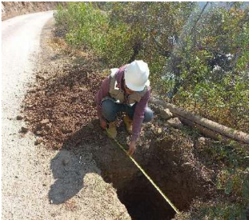
Foto 13: Calicata de 1m por 1m de ancho
