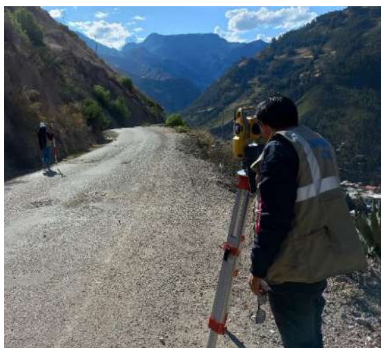
Foto 23: Levantamiento del terreno
