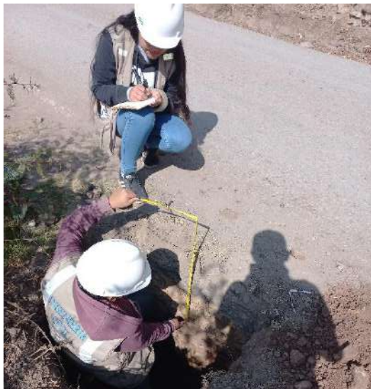
Foto 15: Espesores de la estructura del pavimento existente
