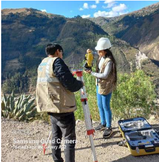
Foto 19: Armado de Estación Total
