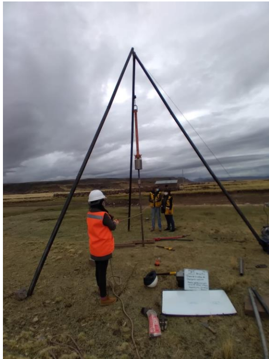
Fotografía 18. Manejo de instrumentos para realización de ensayo SPT in situ.
