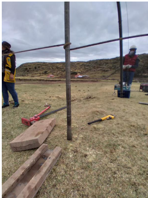
Fotografía 20. Inicio de perforación.
