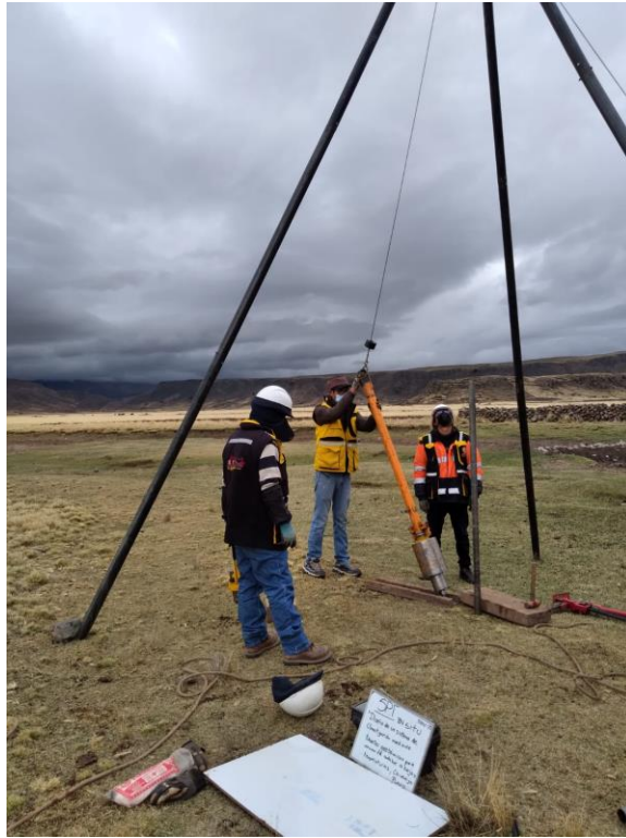
Fotografía 17. Tope y barra para la realización del ensayo SPT in situ.
