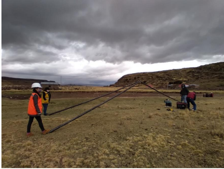
Fotografía 11. Instalación de equipos para ensayo SPT in situ.
