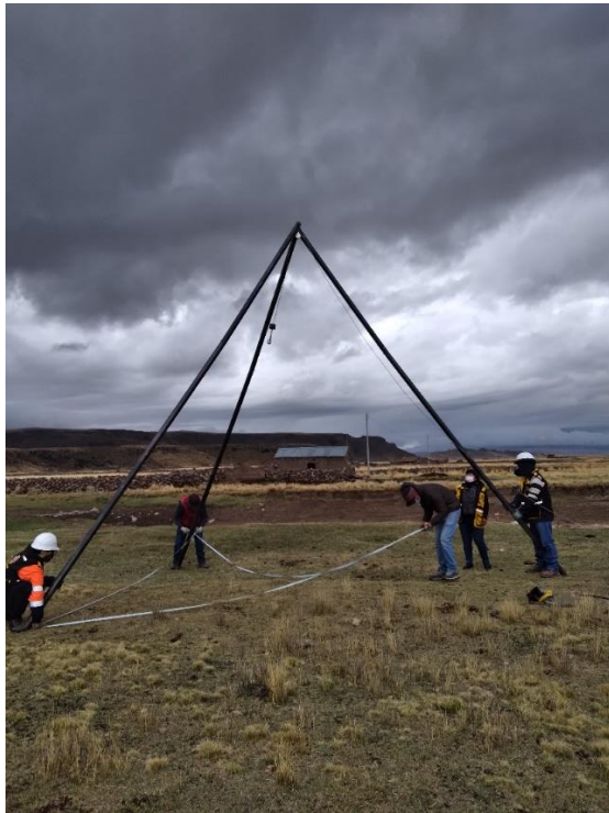
Fotografía 14. Instalación de equipos para ensayo SPT in situ.
