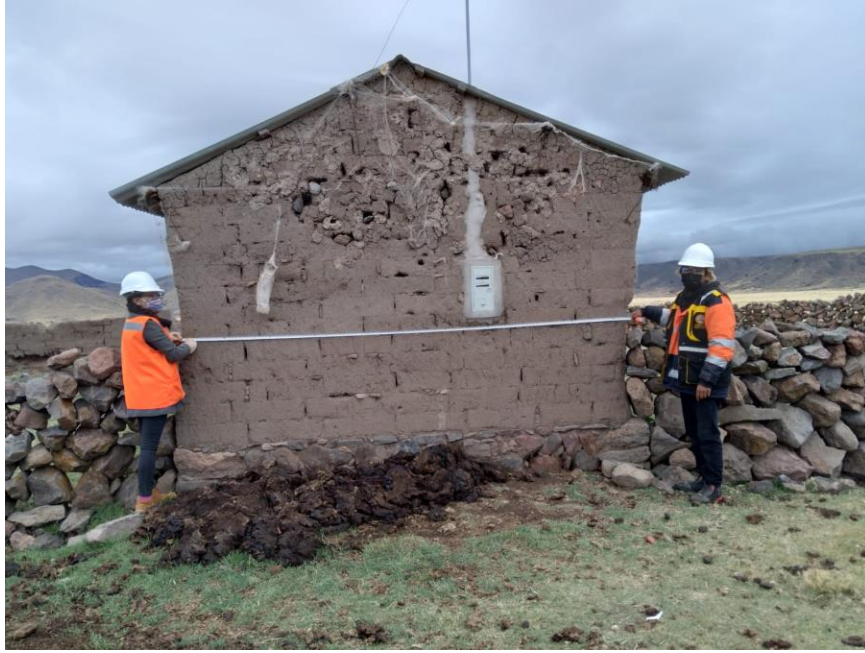
Fotografía 9. Medición de áreas y longitudes. Conexión eléctrica en la vivienda.
