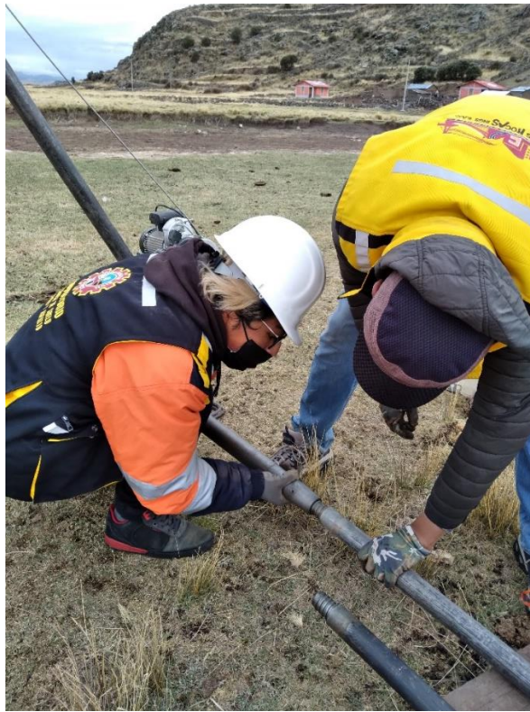
Fotografía 12. Instalación de equipos para ensayo SPT in situ.
