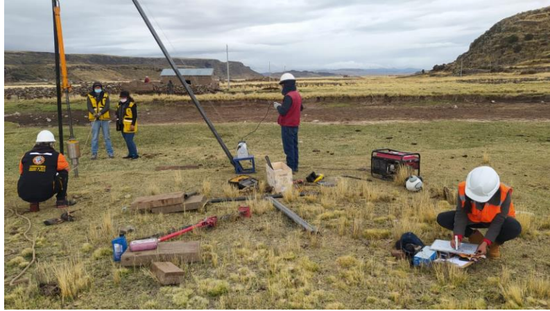
Fotografía 15. Instalación de equipos para ensayo SPT in situ.
