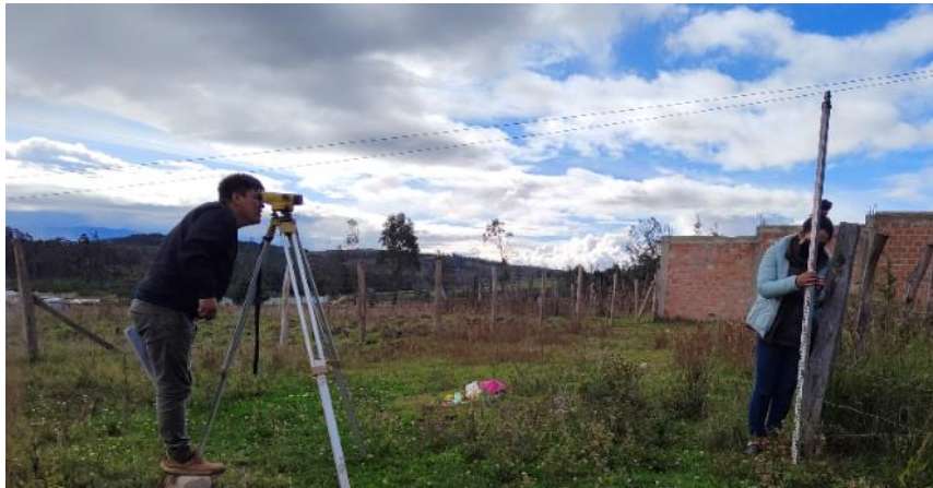
Figura 18. Fotografía del exterior del lugar de intervención.
