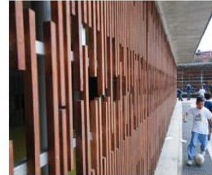
Al diseñar las aulas se orientaron hacia el norte de esta manera se puede obtener una luz natural, de tal manera que implementaron las celosías de madera, para que controle la cantidad de luz natural que pueda ingresar y de igual forma la ventilación.
