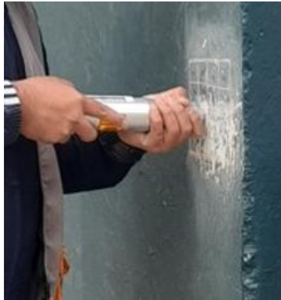
Figura 2. Ensayo de esclerometría para obtener la resistencia del concreto
