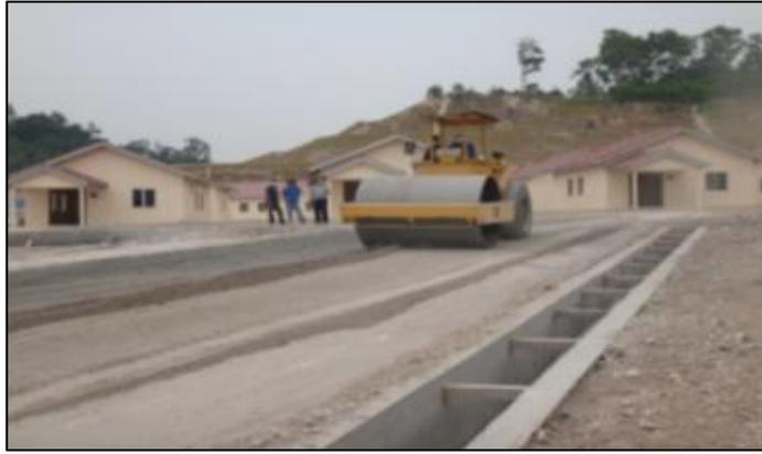
*Figura 8.* Estabilización mecánica
