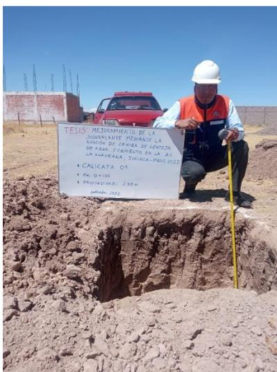
*Figura 9. Excavación de la calicata C-1 (km 0+200)*
