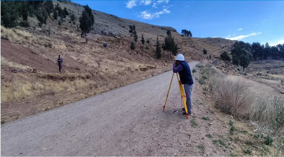
Imagen N° 31 : Se aprecia el levantamiento topográfico en la zona alta para la ubicación del reservorio
