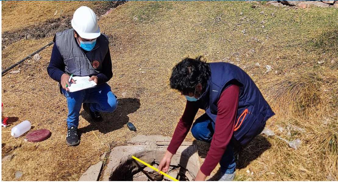
Imagen N° 13 : Se aprecia la medición del diámetro del pozo artesanal N° 01
