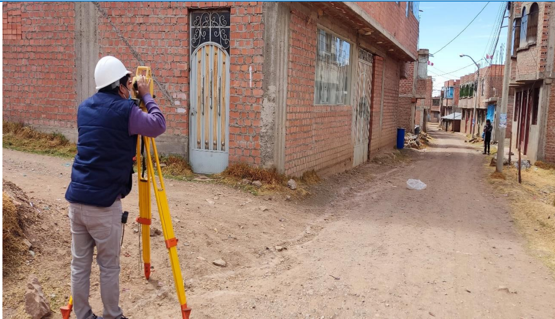
Imagen N° 33 : Se aprecia el levantamiento topográfico en las calles
