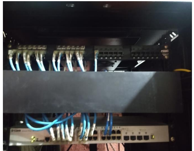
Figura 25: Cableado de la red en el gabinete juntamente con el Switcher en un antes y después
