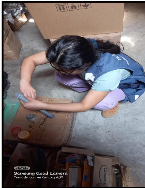
**Imagen 3.** Pegamos las tuberías de 1/2" para su respectiva conexión en los humedales artificiales.
