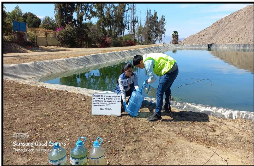
Figura 23 Recolección de muestras de agua residual de la laguna de oxidación para los humedales artificiales con typha dominguensis - eichornia crassipes.
