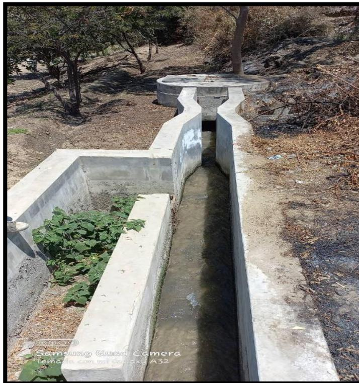
**Imagen 5.** Cribas y desarenadores de la laguna de oxidación de Jimbe.
