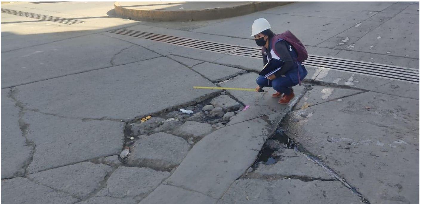
Figura 117. Evaluación de parcheo grande con una severidad alta (29H)
