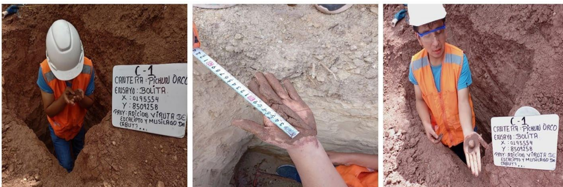
Ilustración 4. Ensayos preliminares del suelo.
