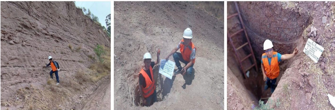
Ilustración 2. Excavación de calicatas.
