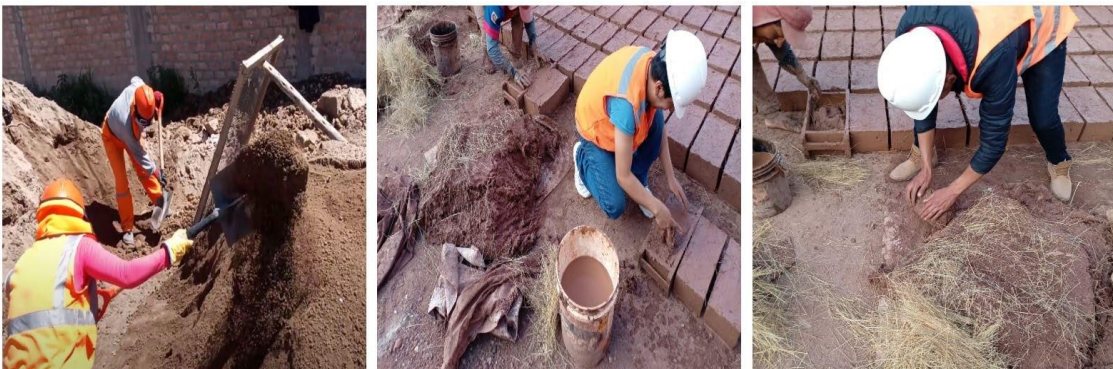
Ilustración 11. Zarandeo del suelo y elaboración del adobe.
